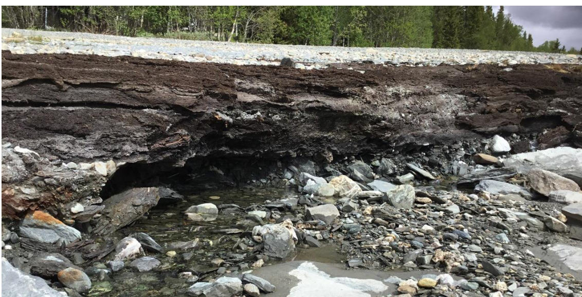
Figur 2-15 Bekken har gravd seg ned til grovere masser/fjell, men det er noe erosjon i gammelt torvlag.
