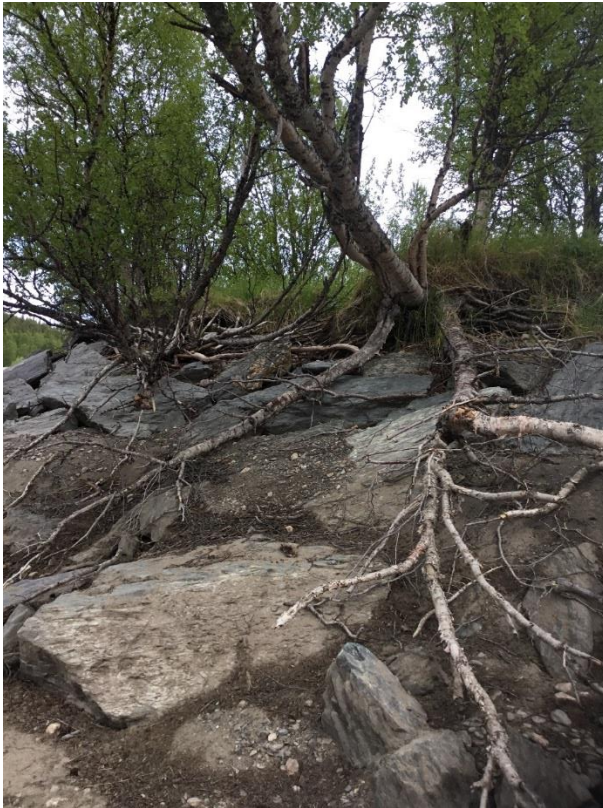
Figur 2-8 Trær på østside av utløp som har blitt vasket frem. Kan med fordel hogges før de havner i Limingen.
