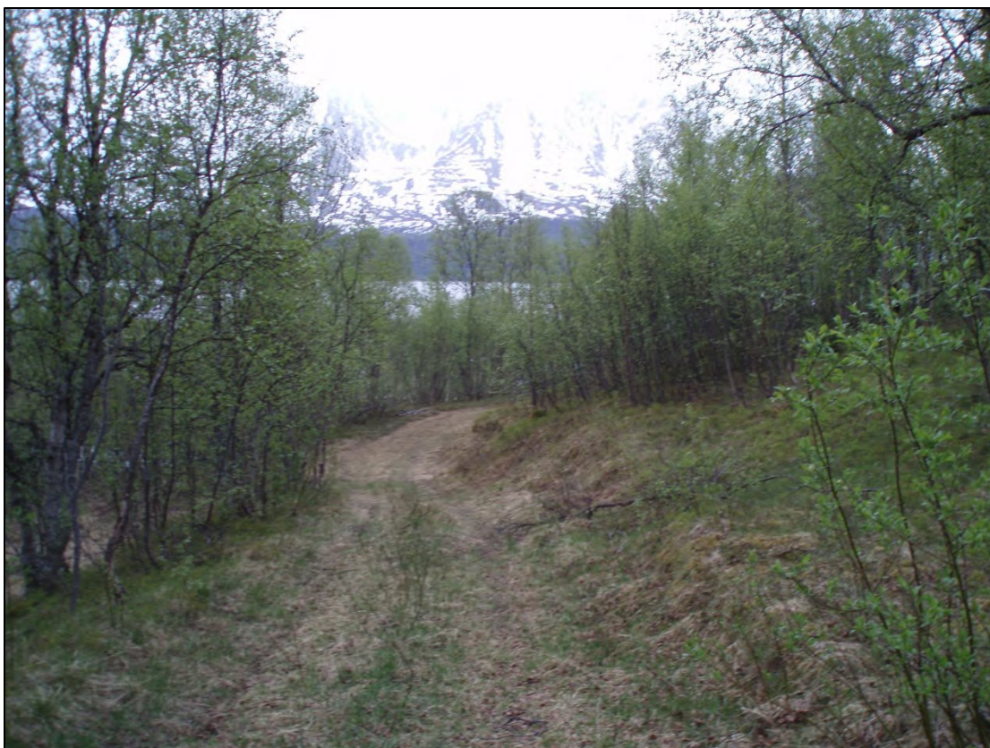
Bildet viser trase for rørgate ned mot kraftstasjon
