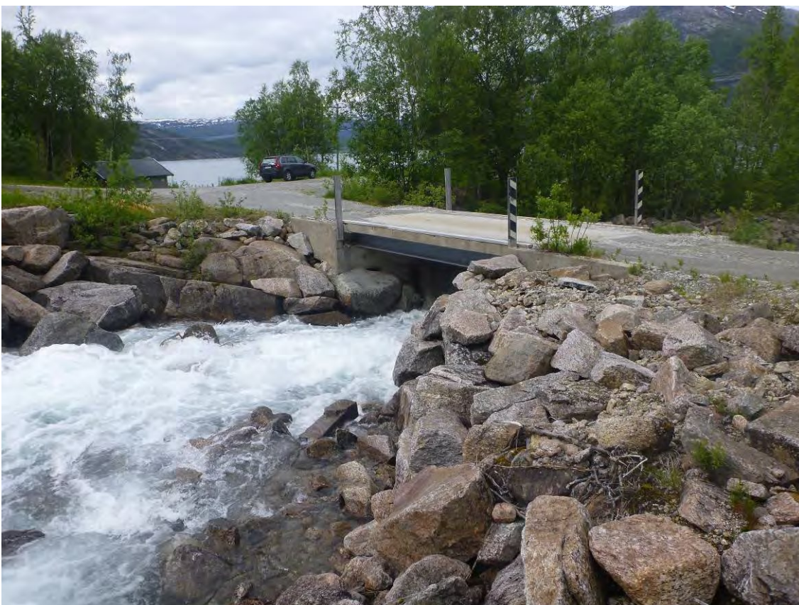
Figur 24 Eksisterende vei til Røyrvatnet kraftstasjon.
