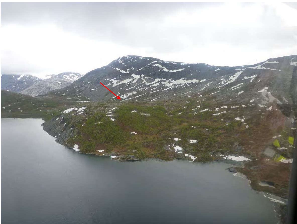
Figur 8 Utløp overføringstunnel anvist med pil.
