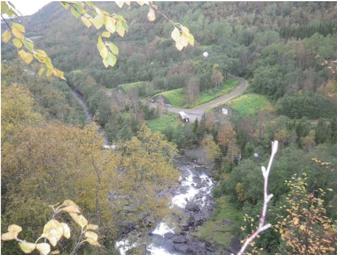
Figur 13 Bildet er tatt fra toppen av Forsen og viser veien og annen infrastruktur opp langs Storelva, samt område hvor det er planlagt midlertidig riggområde og permanent vei til kraftstasjon
