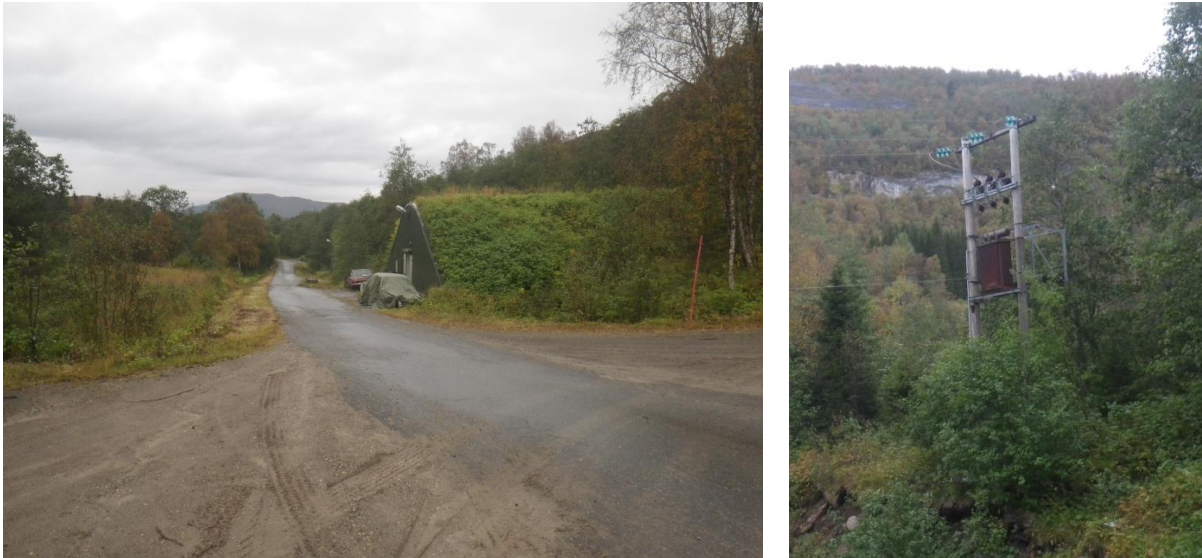
Figur 9. Eksisterende inngrep i prosjektområdet. Venstre bildet viser vei og lagerbygninger ved kraftstasjonsområdet. Høyre bilde viser luftlinje med transformator som krysser elva ved samme område.
