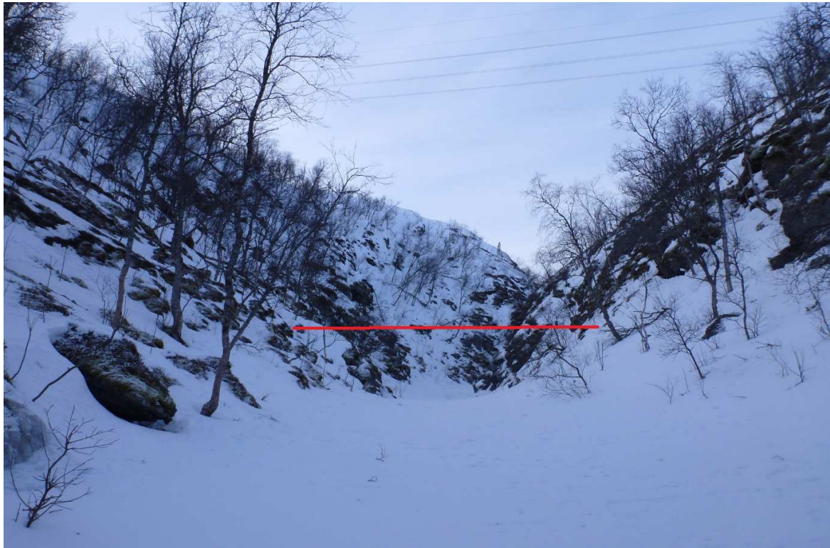
Figur3: Damsted. Høyden på dammen vises med rød strek
