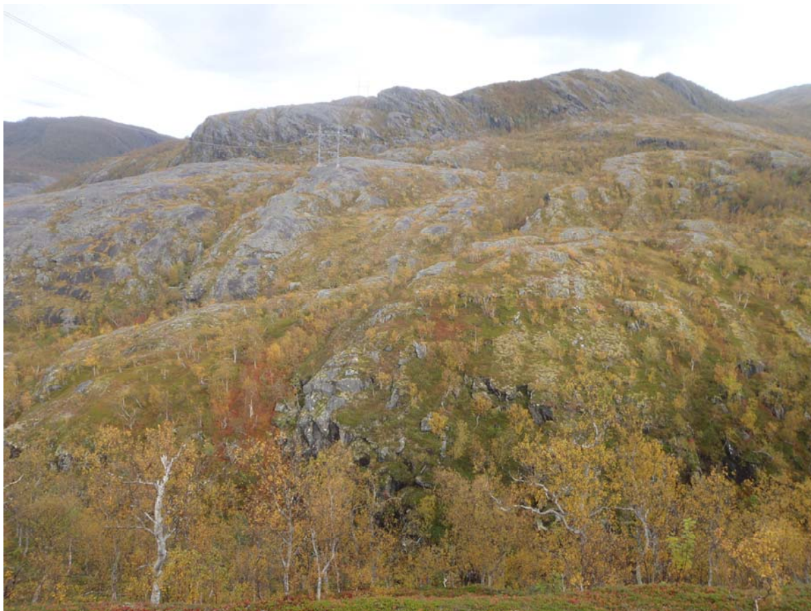
Figur 7 Høyspentlinje over Storelva nedstrøms planlagt inntak
