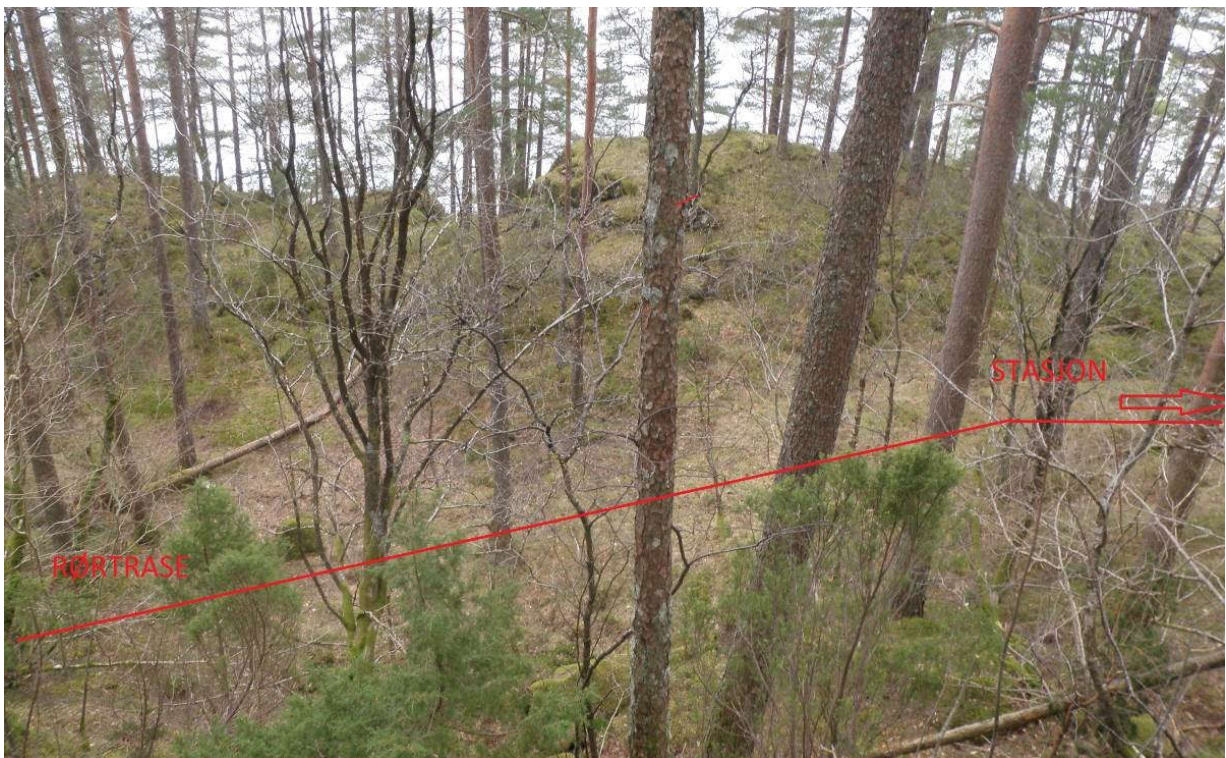
Figur 2.14 Nedre del av rørtraséen over kraftstasjonen
