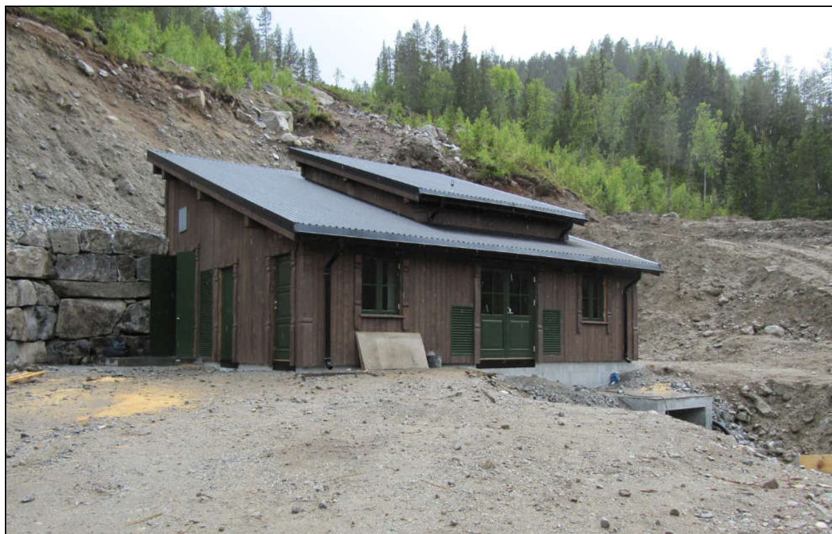
Figur 2.16 Bilde av tilsvarende stasjonsbygg
