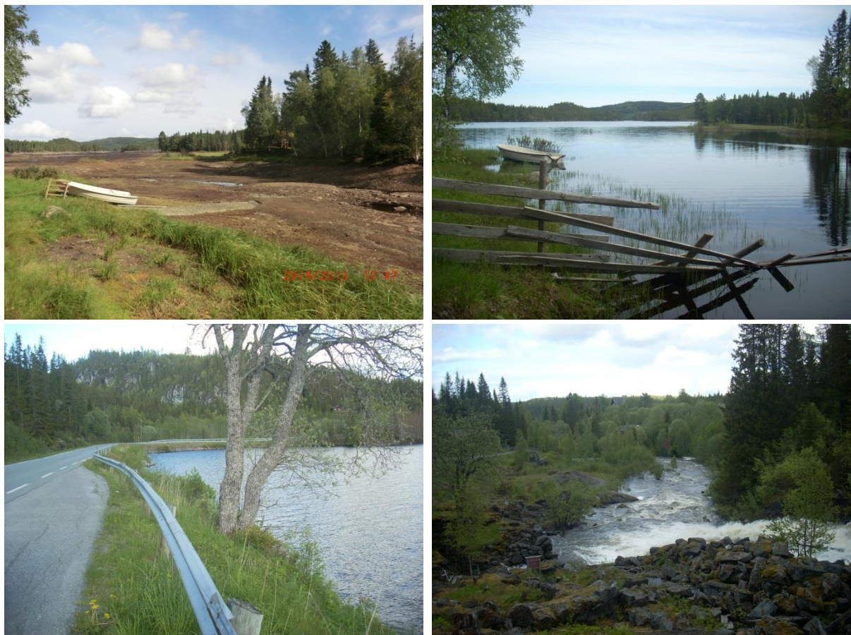
Figur 8: Bildene over viser del av Litlfoldsjøen hhv. ved høy og lav vannstand. Under sees FV963 langs nordøstre del av Foldsjøen (venstre) og Mostadmark jernverk drøye 100 m nedstrøms Foldsjødammen. Foto: Ole Roer.
