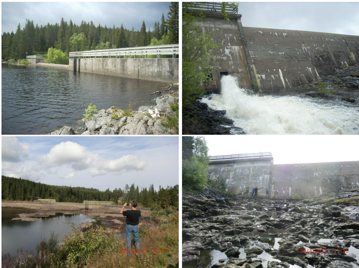
Figur 3: Øvre bilder viser Foldsjødammen ved høy vannstand i Foldsjøen. Bildene under viser dammen ved lav vannstand. Foto: Rolf Amundsen og Ole Roer.
