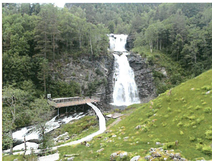
Figur 3-12. Bildet fra området like nedstrøms den planlagte kraftstasjonen, med opparbeidet konsertscene og rekreasjonsområder.
