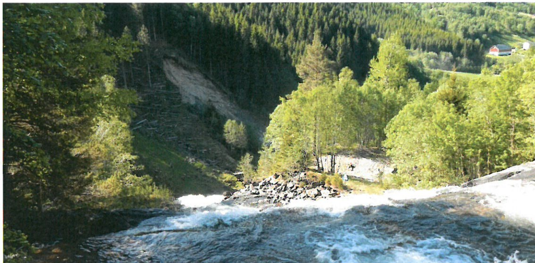
Figur 3-5 Oversiktsbilde tatt fra planlagt kraftstasjonsområde. Utglidning av masser vises i bakgrunnen.
