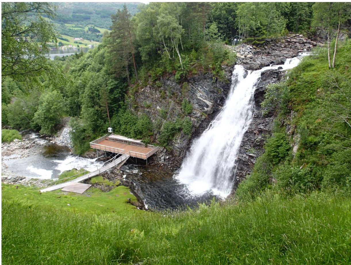
Figur 8. Like nedstrøms planlagt kraftstasjonsområde ligger reservevanninntak med rensehus for settefiskanlegget (øverst midt i bildet), samt scene og rekreasjonsområder tilknyttet Storfossen.
