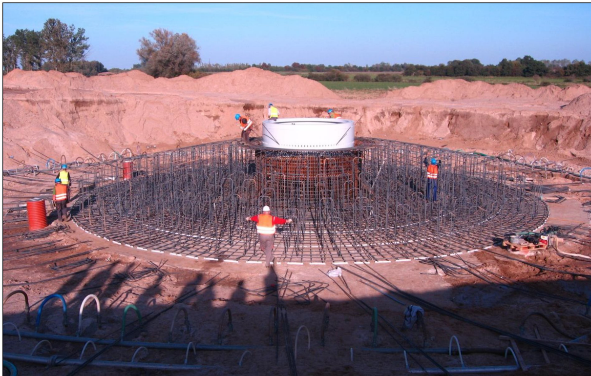
Figur 5. Eksempel på etablering av gravitasjonsfundament.
