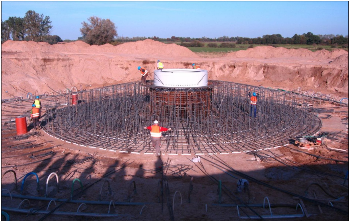
Figur 6. Eksempel på etablering av gravitasjonsfundament.
