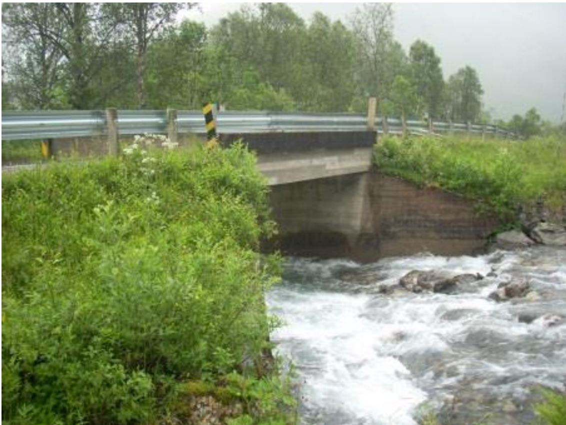
Bildet viser Fv294 som krysser Reipkrokelva ved kote 7 rundt 140 meter nedstrøms kraftstasjonen.
