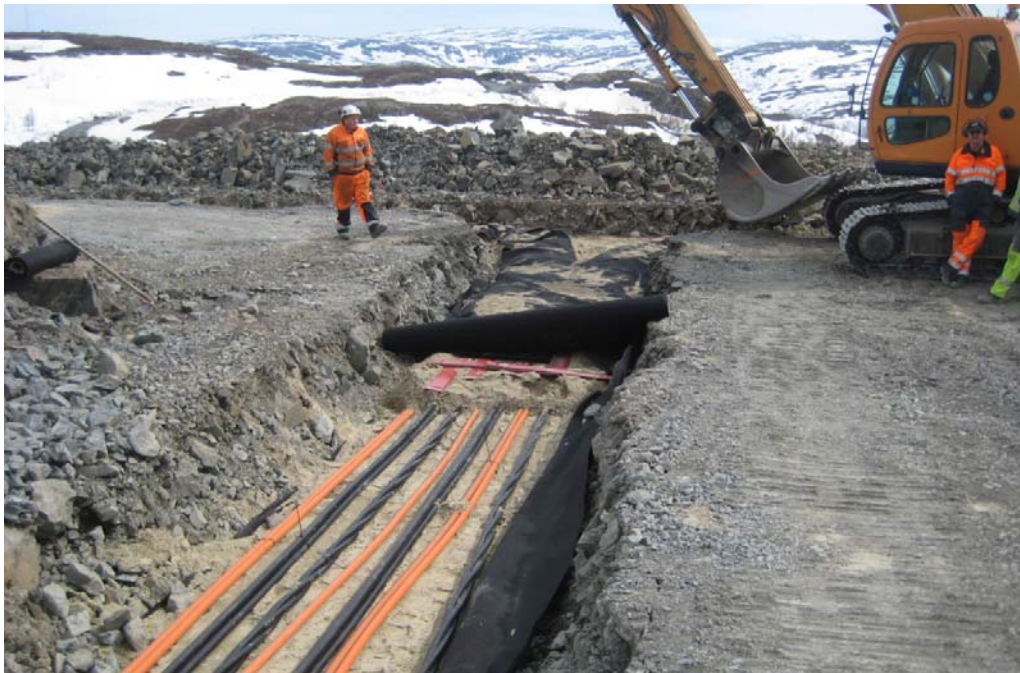
FIGUR 12: BILDE FRA KABELLEGGING PÅ NYGÅRDSFJELLET VINDPARK, NARVIK KOMMUNE
