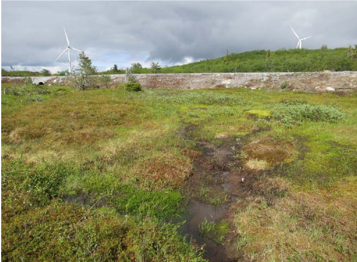
Figur 6: Eksempel på oppbygging av vei gjennom myr hvor kulvert er ført gjennom vei, til venstre i bildet. Veien er lagt med god høyde over myra og med bratte vegkanter for å minimere inngrepsområdet og bevare mest mulig av den naturlige vegetasjonen. Bildet er tatt av Rambøll i forbindelse med et kontrollprogram for hydrologi for BlaikenVind AB.
