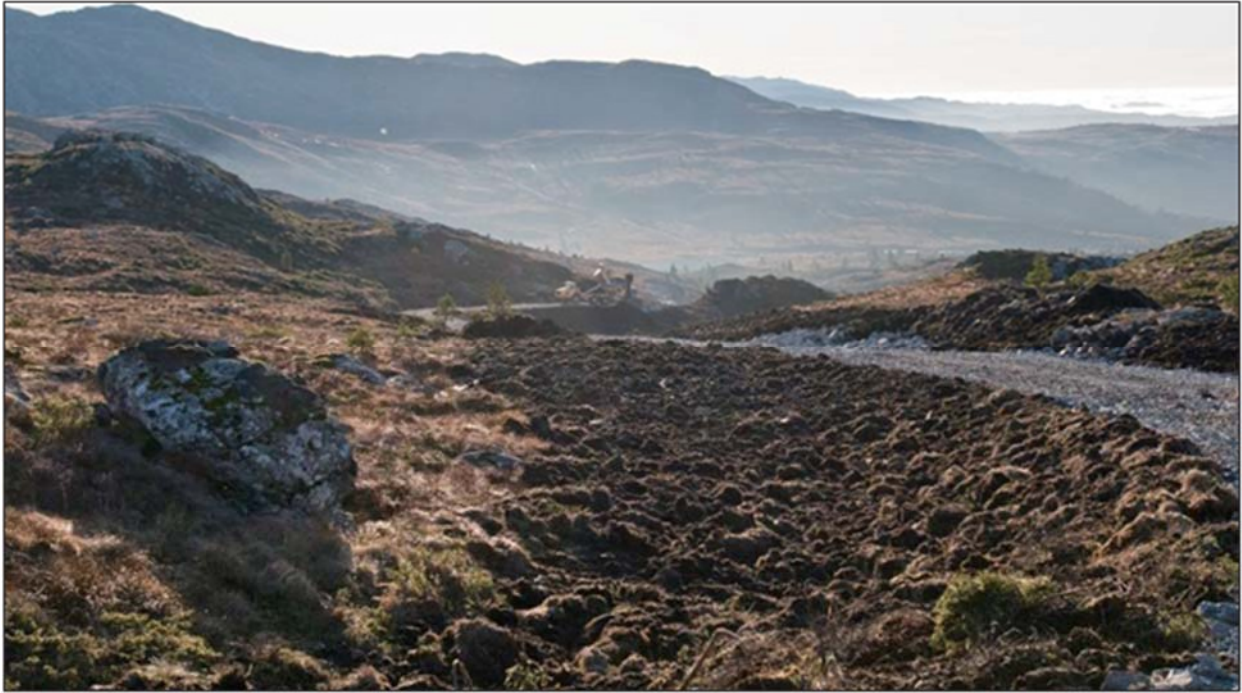
Figur 21: Der det ikke er mulig å få lagt tilbake flak av toppdekket, skal massene legges forsiktig ut på sideterrenget som skal dekkes, uten å klappe til eller kompaktere massene. Det kan kanskje se uryddig ut den første tiden, og på nært hold, men dette vil i lengden gi et mer naturlig resultat. Eksempel fra Midtfjellet vindpark. Foto: Einar Berg
