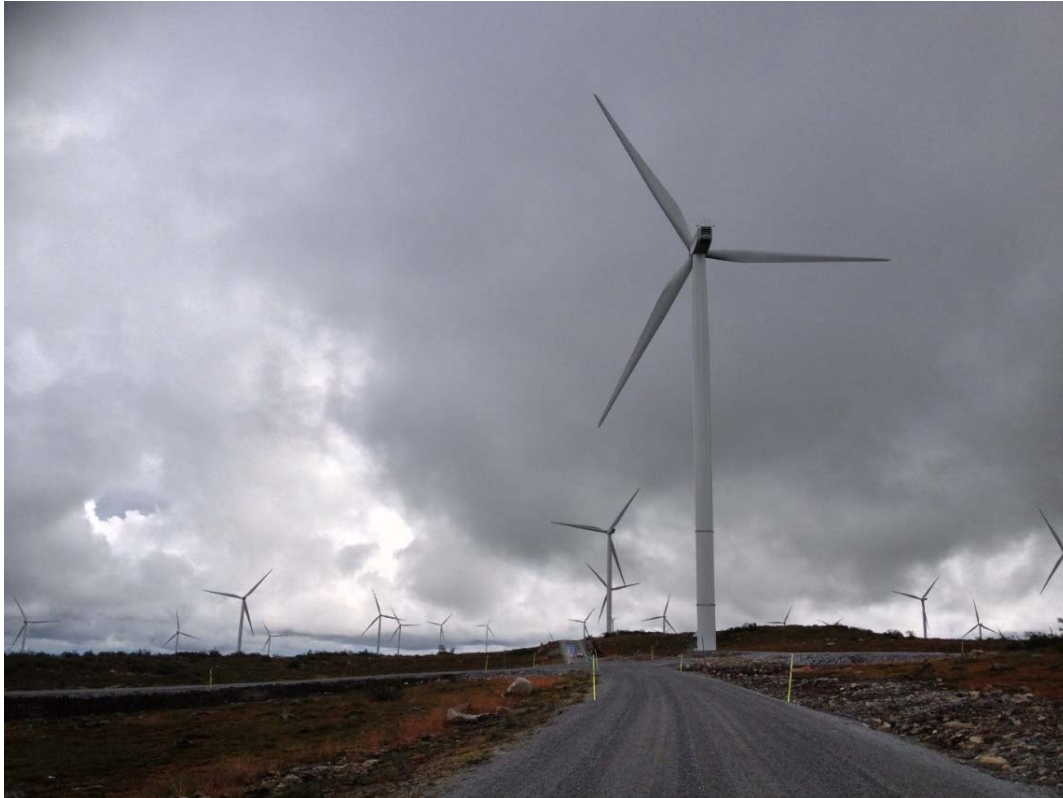
Figur 10: Eksempel fra Blaiken hvor veiene ligger fint i terrenget med gjennomtrengelige voller, uten for høye grøfter
