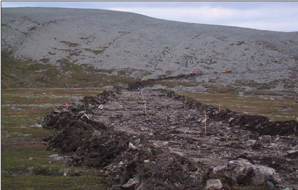
Figur 20: Toppdekket skaves av og legges i ranker på siden. Det er viktig at topplaget legges tilbake så fort som mulig og ikke mellomlagres for lenge. Eksempel fra Kjøllefjord vindpark. Foto: Svein-Rune Wian
