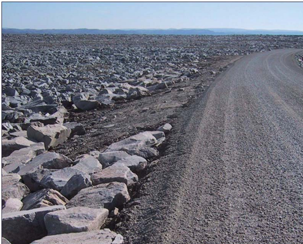
Figur 13: Det vil ikke være nødvendig med grøfter langs veien der det er så godt drenerende masser som her. Overgangen mellom inngrep og eksisterende terreng utføres så mykt som mulig. Stein med fin patinering tas vare på og plasseres tilbake i terrenget med den patinerte siden opp. Fra Kjøllefjord vindpark. Foto: Svein-Rune Wian
