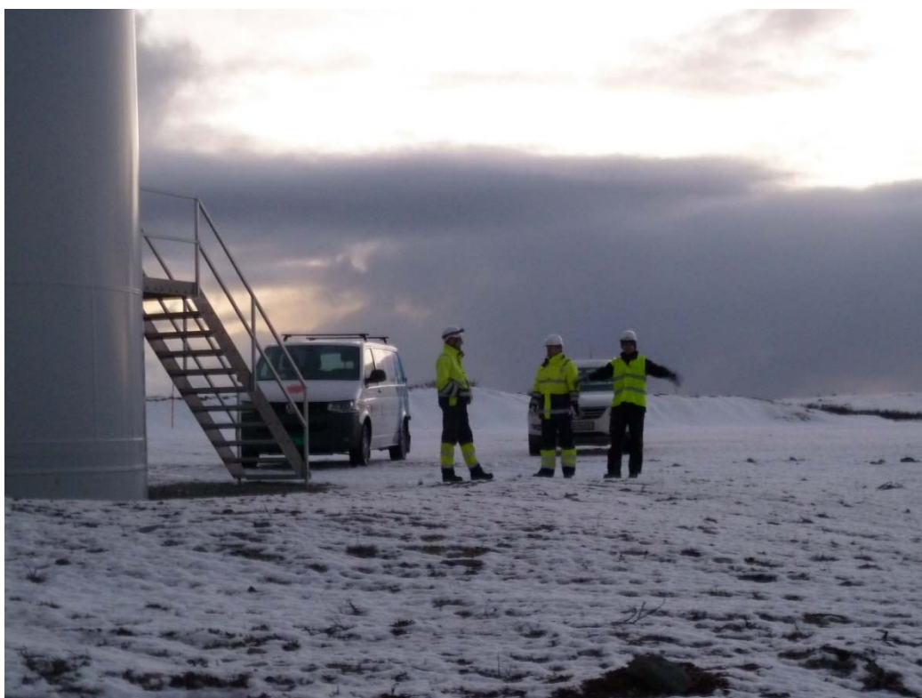
Figur 19: Bilde fra Fakken vindkraftverk. Ryddig fundament og kranoppstillingsplass i samme nivå. Foto Ulf R. Hanssen.
