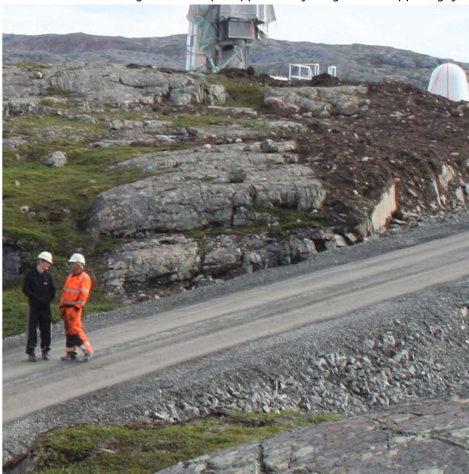
Figur 14: Ved å trekke massene nedover skjæringen og inn i skjæringsfoten vil man få en bedre landskapstilpasning og visuell forankring.
