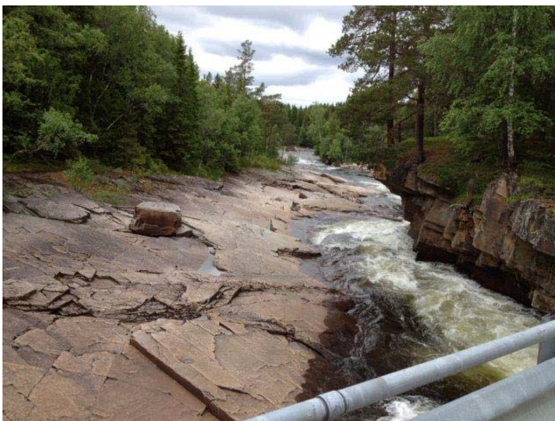
Figur 5.2: Bru som krysser elva like nedstrøms inntaksplassering ved omtrent kote 95.
