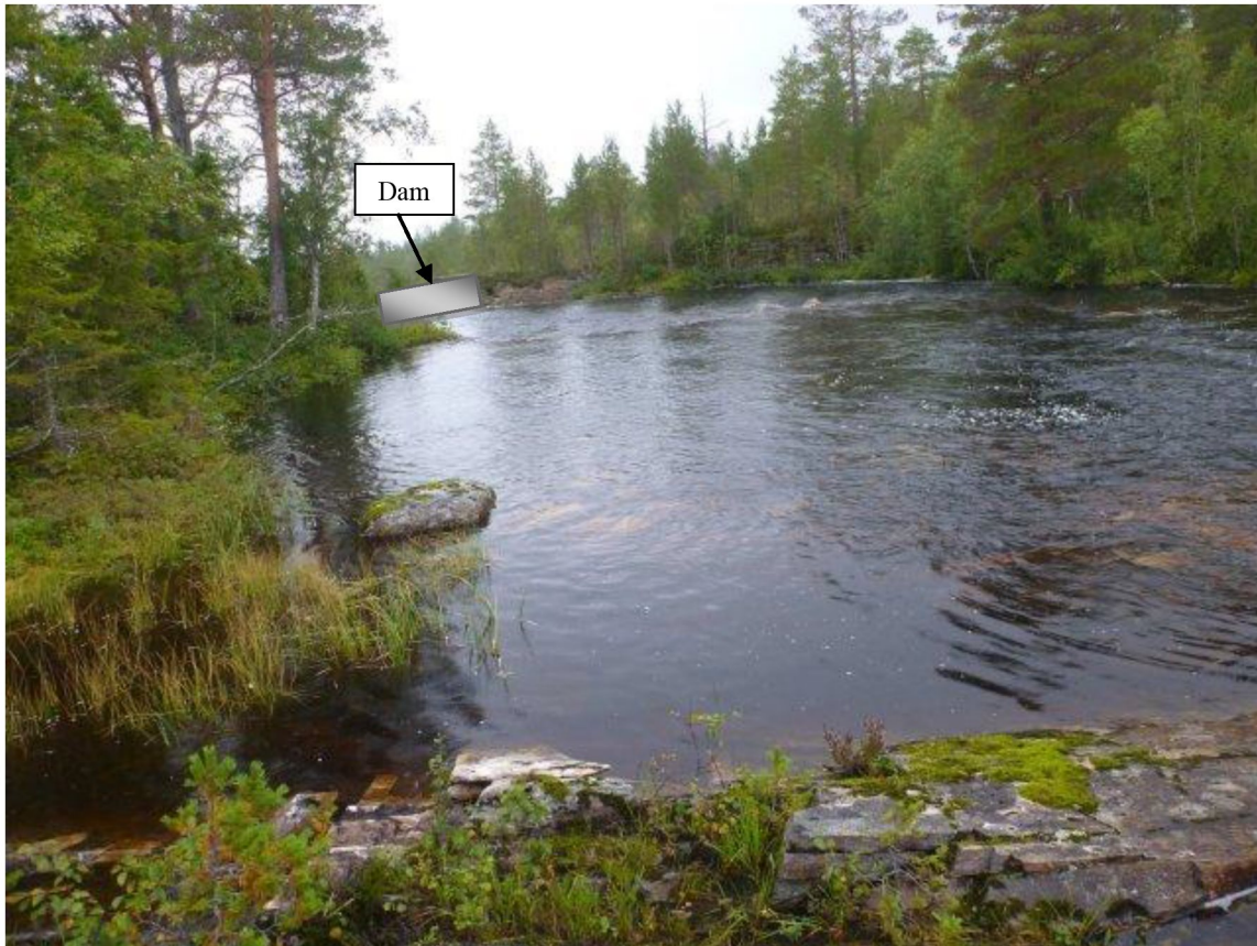
Figur 3.1: Ved planlagt inntak i utløpet av Bjørtjønnna. Dam knyttes til berg i bakkant av bildet.
