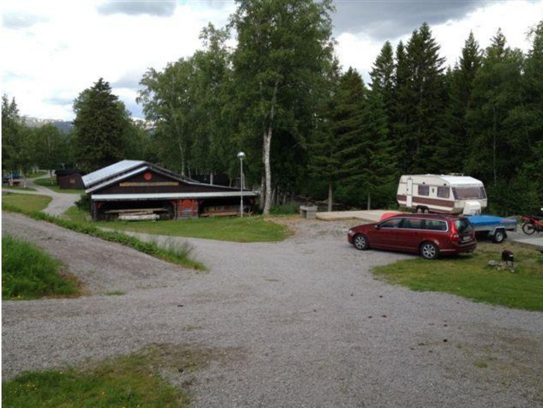
Figur 3.8: Ny kraftstasjonsbygning blir like ovenfor den gamle saga i bakgrunnen.
