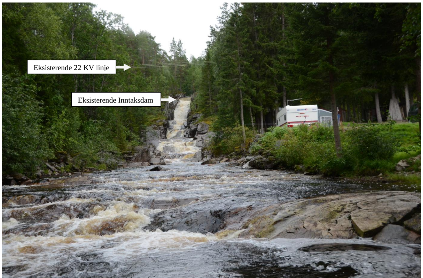
Figur 3.9: Eksisterende inntaksdam sees øverst i kløfta. Eksisterende kraftverk sees bak campingvogna. Den nye kraftstasjonsbygningen blir til høyre på bildet. Vannspeil i forkant av bilde blir vannstand i avløpskanal.
