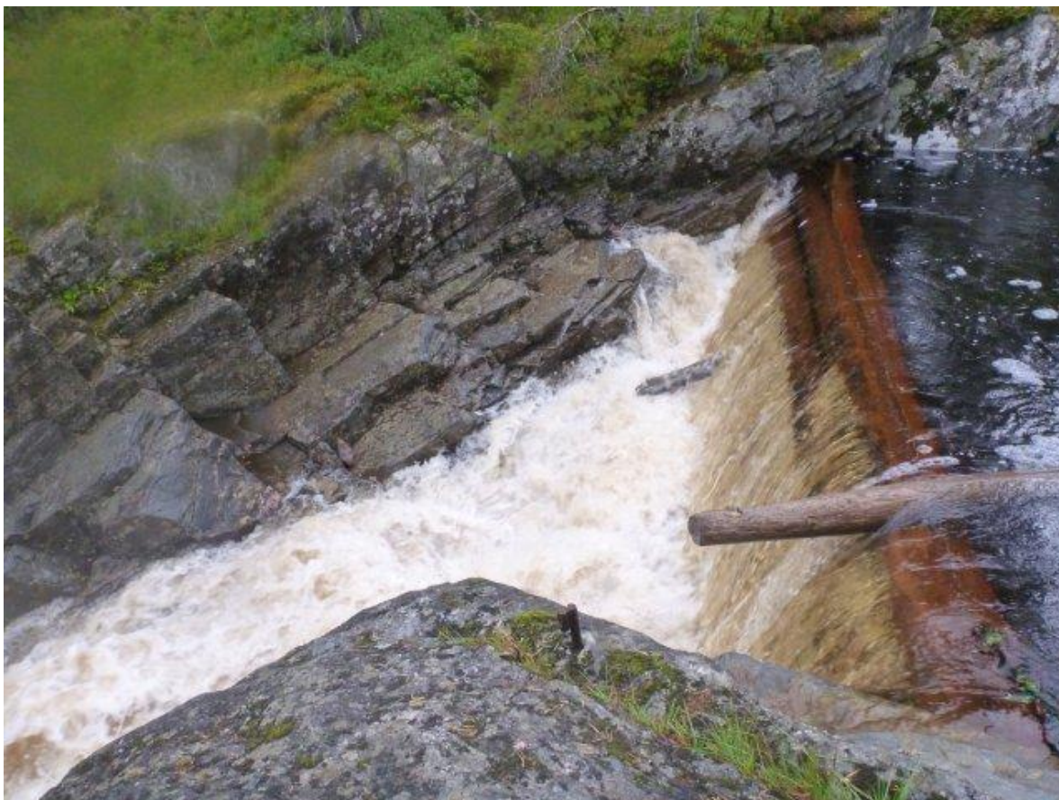
Figur 3.7: Inntak for eksisterende kraftverk ca. kote 43.
