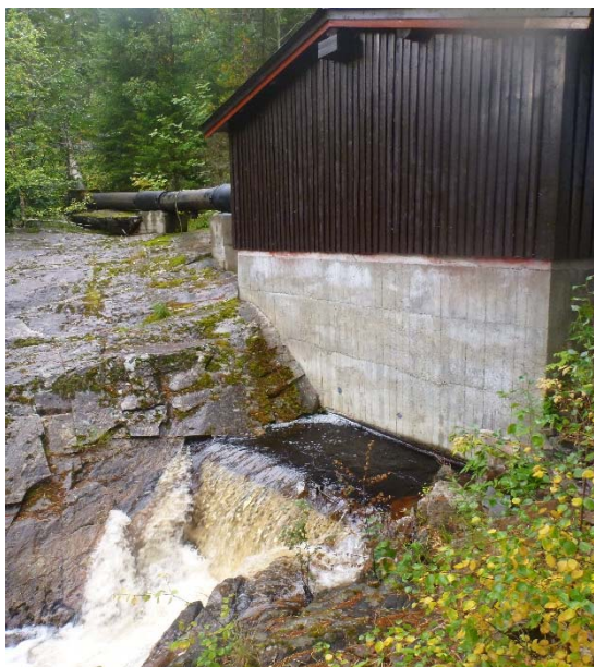
Figur 1.2 Eksisterende kraftverk i Strindelva i drift
