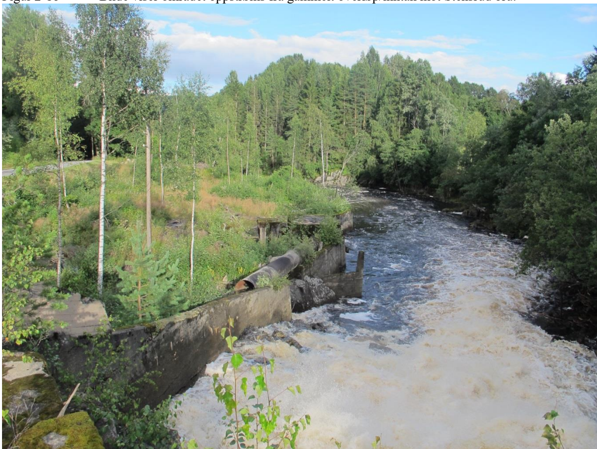
Figur 2-11 Området nedstrøms fra gammelt inntak samt stasjonsbygning, rørgate og fløtningsvegg
