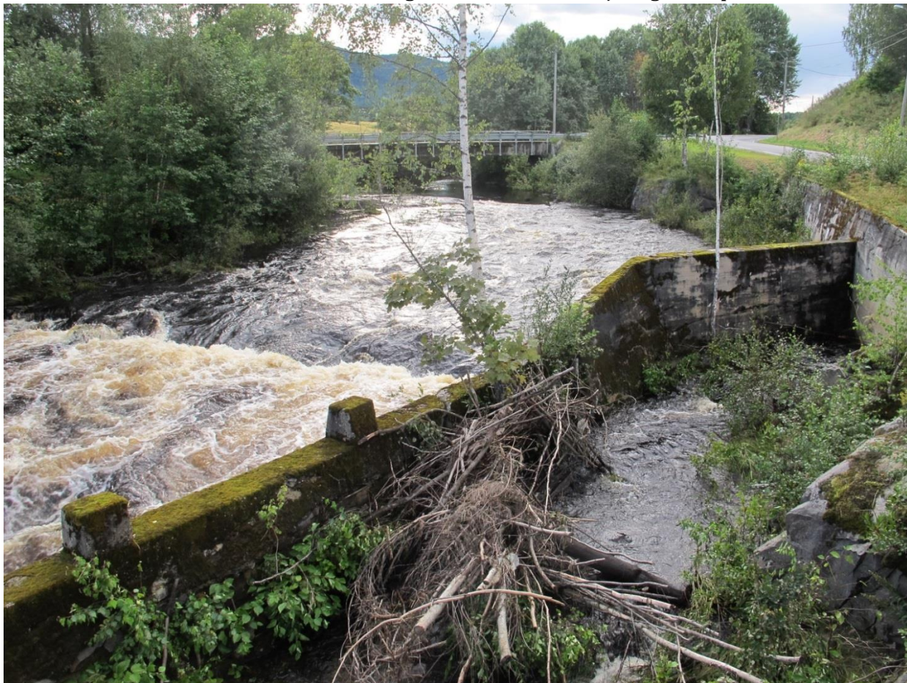
Bilde 3.8 : Viser rester av gammel damkonstruksjon og overløp
