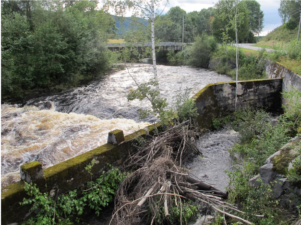
Figur 2-10 Bilde viser området oppstrøms fra gammelt overløp/inntak mot Stensrud bru.
