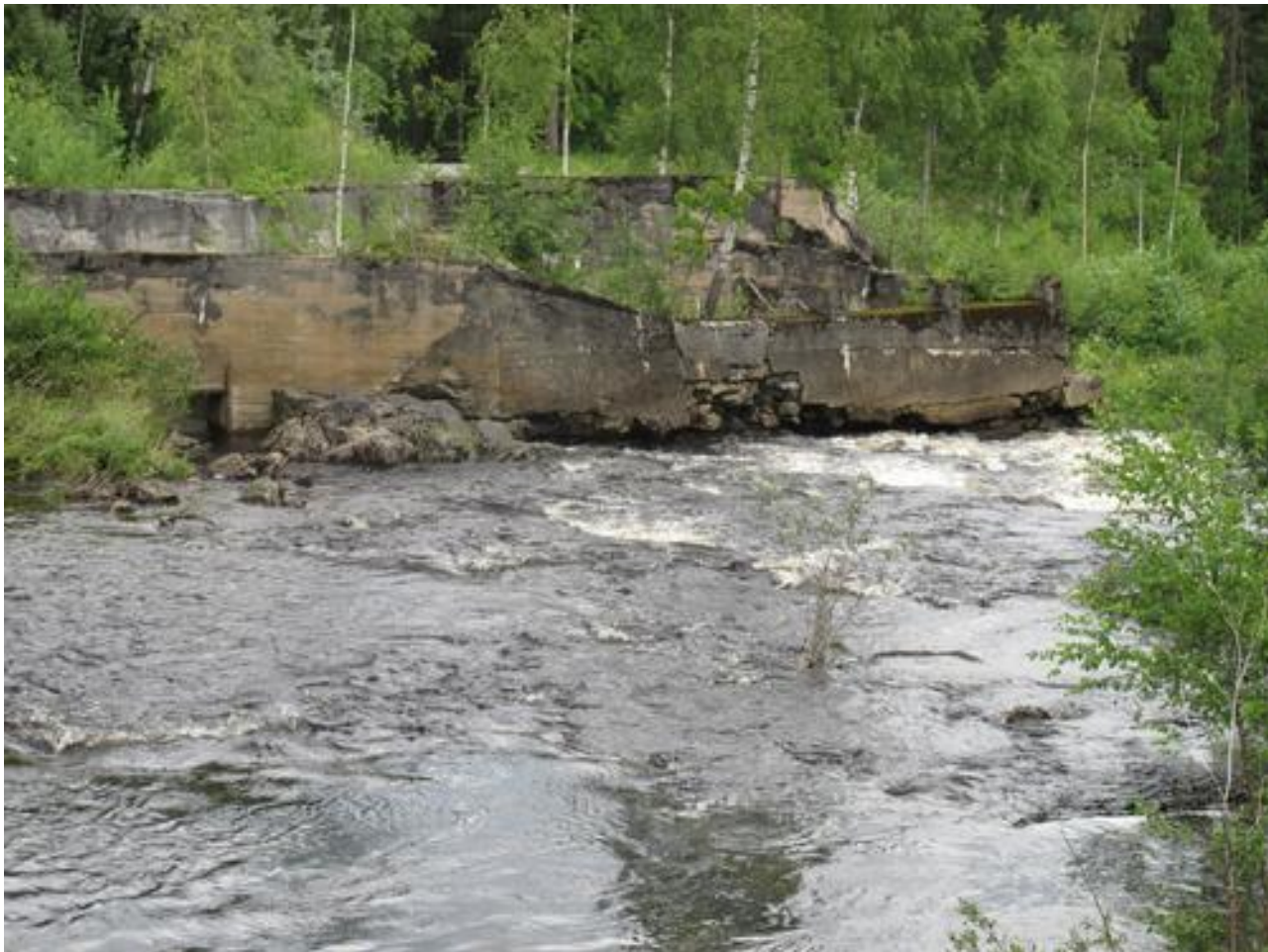
Bildet 3.7 : Viser rester av damkonstruksjon og overløp
