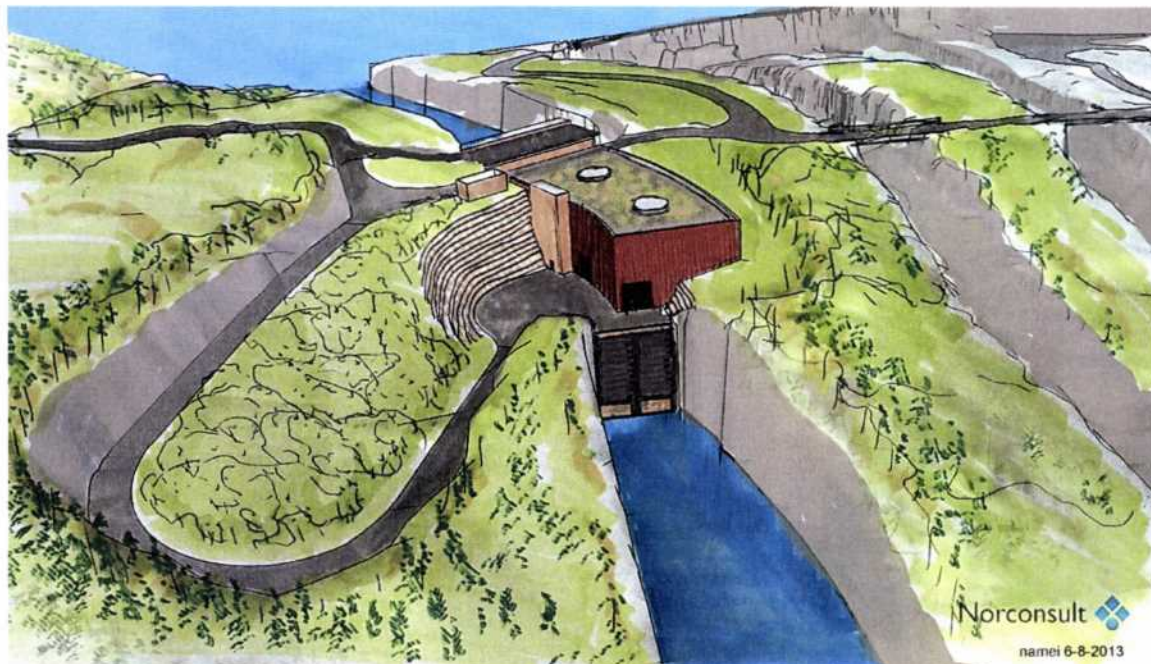
Figur 5 En arkitektskisse (basert på en 3D-modell) viser hvordan Vamma 12 kan komme til å se ut (sett fra øst). Atkomstveien til eksisterende Vamma kraftverk er planlagt lagt om slik at den går over taket til kraftstasjonen, som er tenkt fritt tilgjengelig.
