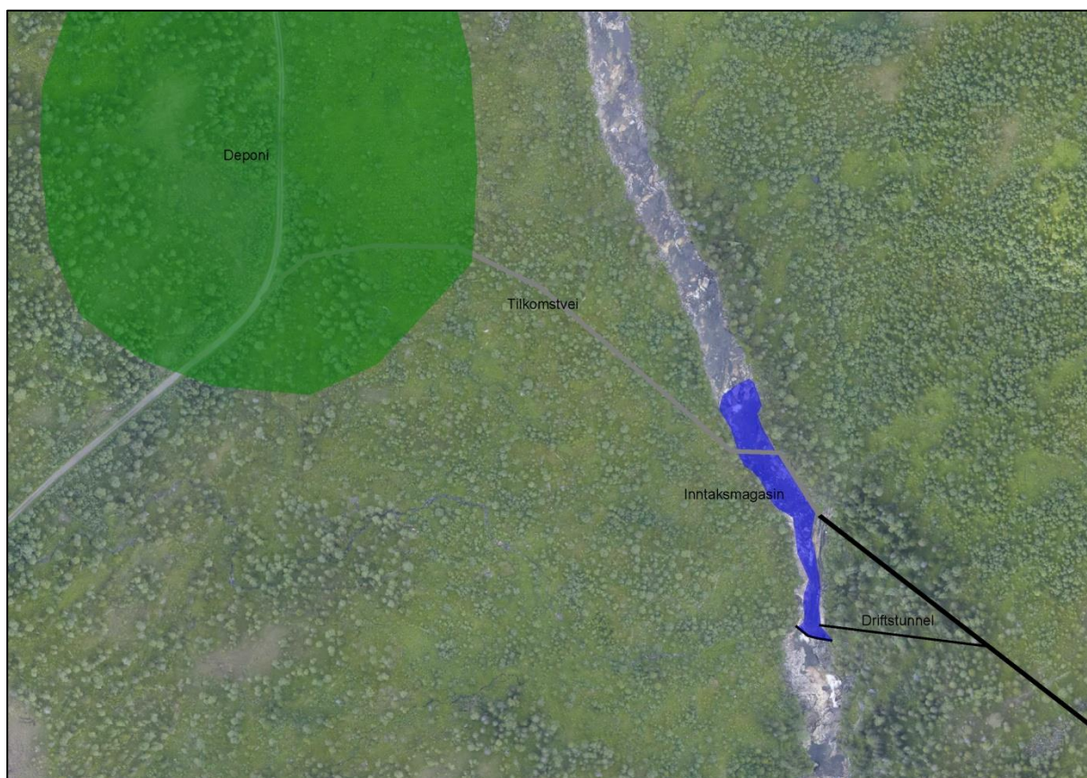
FIGUR 10: FLYFOTO MED INNTEGNET INNTAKSOMRÅDE FOR VESTERELVA KRAFTVERK.
