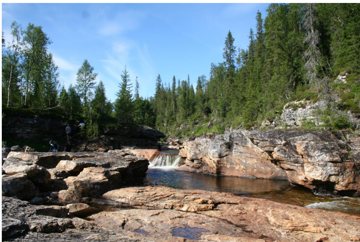
FIGUR 28: DAM PLASSERS PÅ NATURLIG TERSKEL I ELVA, RETT FRAM I BILDET. TUNNEL OG INNTAK RETT TIL HØYRE FOR DAM.
