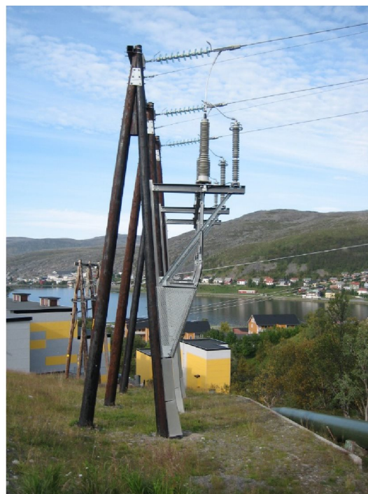
Figur 4. Prinsippskisse 132 kV trestolpemast (venstre). Normal mastehøyde 12-15 meter, men med enkelte mastepunkt rundt 20 meter. Faseavstand er normalt 5 meter hvilket gir en totalbredde på travers på ca. 10 meter og 5 meter mellom
