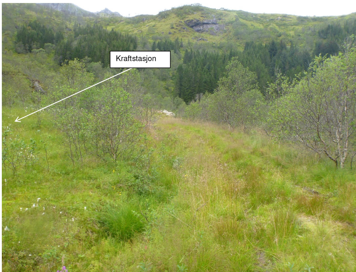
Eksisterende traktorvei og kraftstasjon
