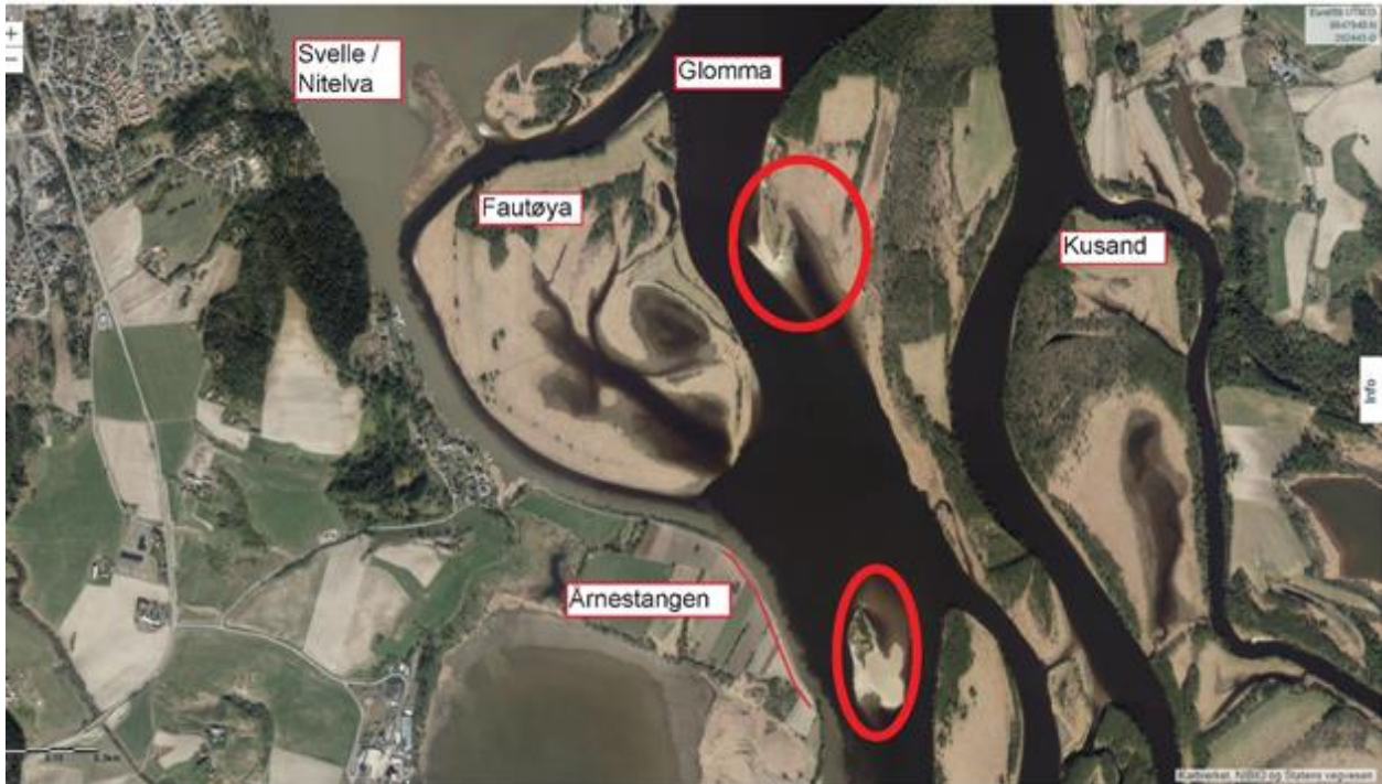
Figur 22 Dette flybildet fra 2019 viser hvordan blakket vann fra Nitelva stryker ned langs Årnestangen, hvor den kartlagte strekningen er markert med tynn rød linje. Erosjonsprosessen ved Årnestangen påvirkes av forholdene i Nitelva, og kan forklare at variasjonen i årlig erosjon er noe annerledes ved Fautøya og Kusand hvor erosjon påvirkes av vannføring i Glomma. Røde sirkler angir avsetningsområder, hvor sedimenter skaper oppgrunning og nytt terreng. Utviklingen påvirker erosjonshastigheten ved at vannføringen blir presset over mot Fautøya og Årnestangen.
