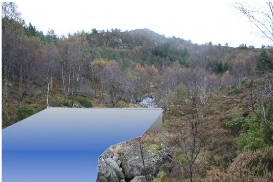
Figur 26 Dam/vasspegel sett frå oppstrams side
