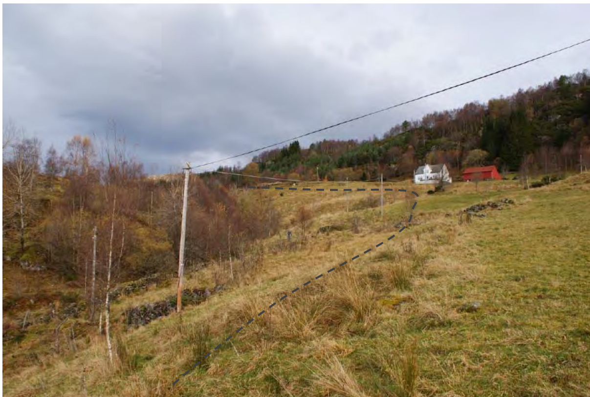
Midtre del av rørtrasèen sett oppover. Bygninger på bildet tilhører garden Skjolda.
