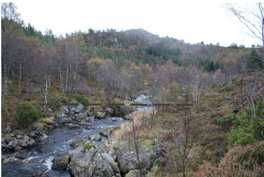
Damområdet sett fra oppstrøms side. Overkant dam illustrert med stipla linje.
