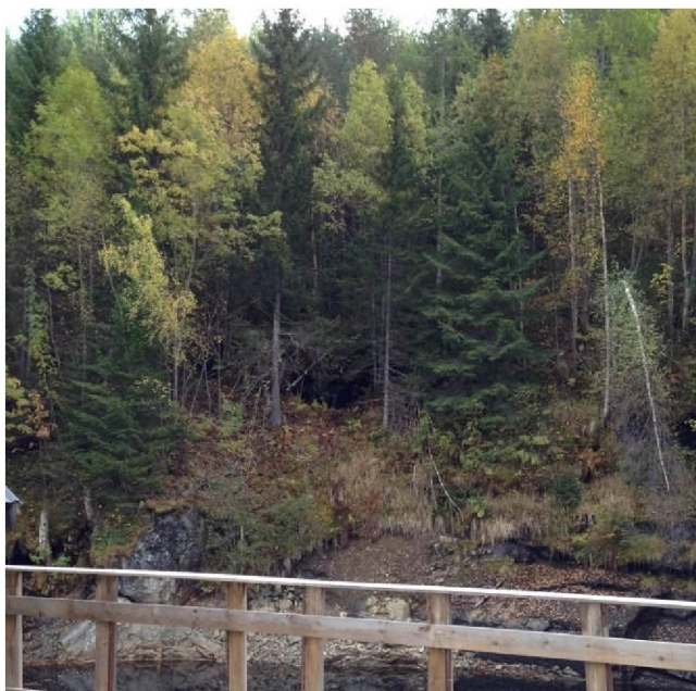
Bilde 7: Kraftstasjonsområde på sørsida av dam Medåe I. Foto: Clemens Elvekraft AS.
