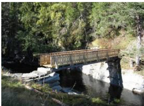
Bilde 10: Gangbru oppstrøms demning til Nørståe I. Foto: Elvekraft
