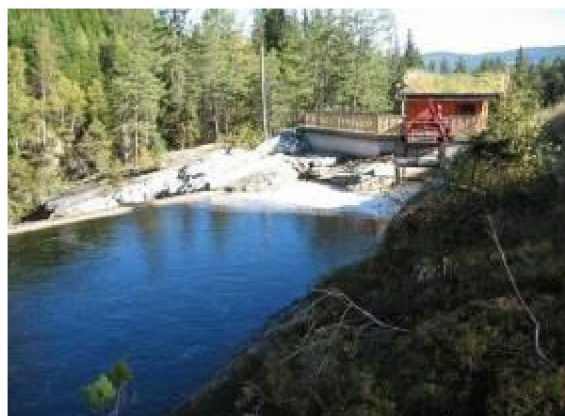
Bilde 11: Inntaksbasseng Nørståe I. Foto: Elvekraft
