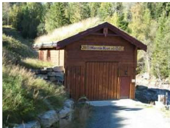
Bilde 9: Kraftstasjon Nørståe I. Foto: Elvekraft
