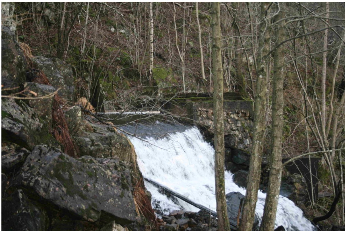
Figur 16. Noen hundre meter oppstrøms den planlagte kraftstasjonen ble det i 1950-årene etablert et vanninntak beregnet for drift av et kommunalt vassverk. Vassverket er ikke i bruk lenger, men kommunen sitter fremdeles med de fallrettene de tilegnet seg i forbindelse med etableringen. (Kilde; Per Hompland). Ved siden av inntaket er det en liten foss. (Foto; Karl Johan Grimstad © 21.11.2011).
