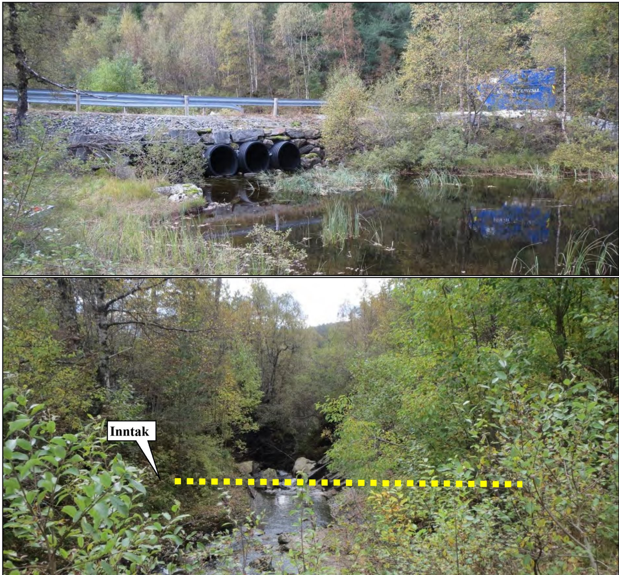
Figur 10 Utløp av Markosvatnet (øverst) og planlagt inntak like nedstrøms utløpet.
