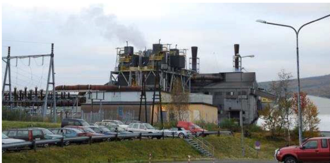
Figur 7-9. Finnfjordbotn transformatorstasjon og Finnfjord smelteverk.
