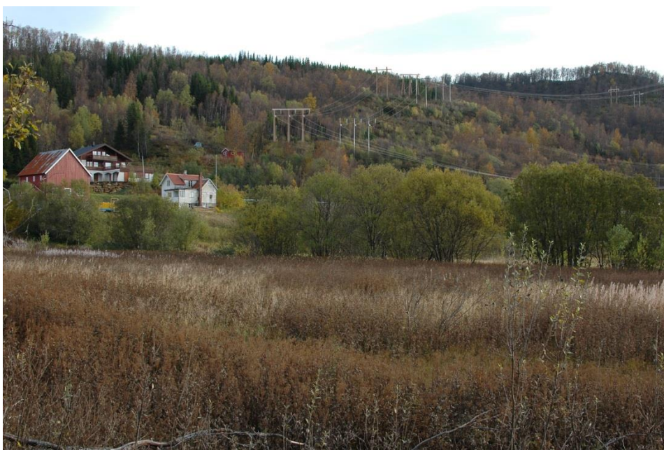
Figur 6-8. Visualisering av ny kraftledning ved Finnfjord etter sanering av gammel ledning. Ledningen til høyre på bildet er den ledningen som i dag står lengst til venstre.
