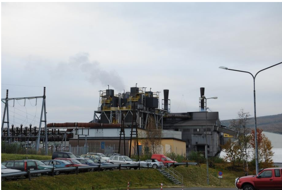
Figur 5-12. Finnfjordbotn transformatorstasjon og Finnfjord smelteverk.
