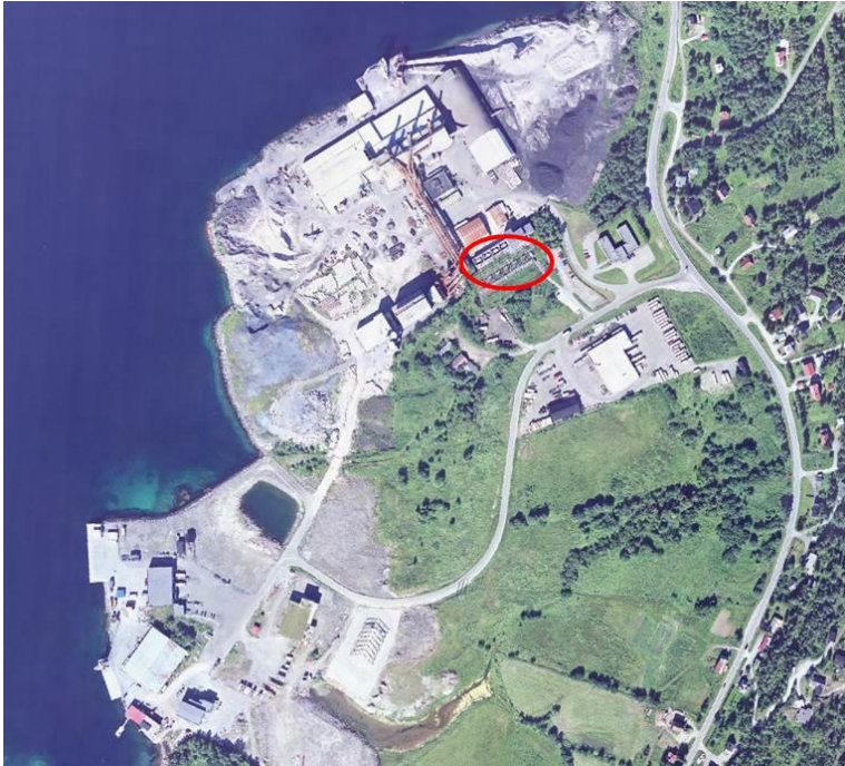
Figur 5-13. Ortofoto av Finnfjord smelteverk og Finnfjordbotn transformatorstasjon (merket med rød ring). Utsnitt er hentet fra kart.gulesider.no.
