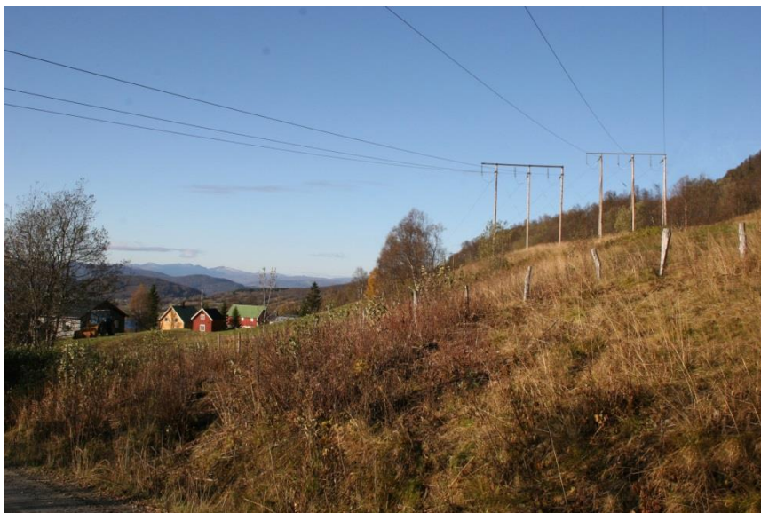
Figur 6-3. Dagens situasjon på Nordli.
