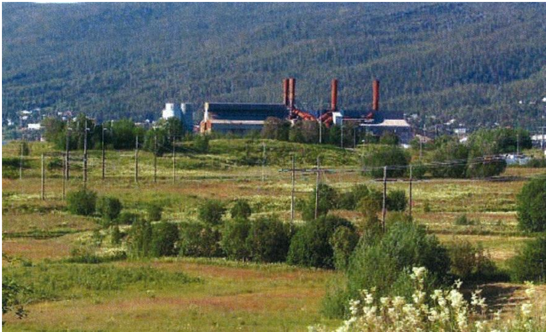
Figur 5-10 Finnfjord smelteverk med linjer over et myrlendt terreng. Foto Ø. Sundquist.
