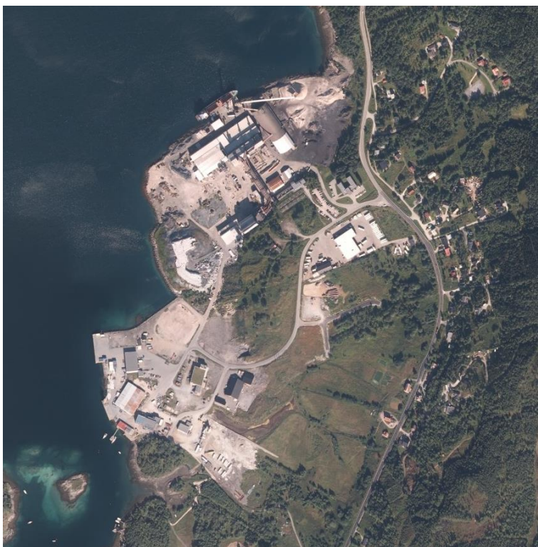
Figur 5-12. Flyfoto av Finnfjordbotn transformatorstasjon, smelteverk og annen industri. Kartutsnitt er hentet fra Norgeskart.
