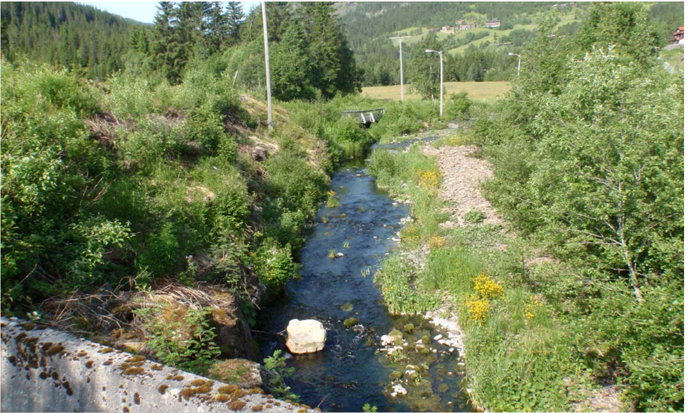
Datert 15.07.13 - vassføring: minstevannføring +
