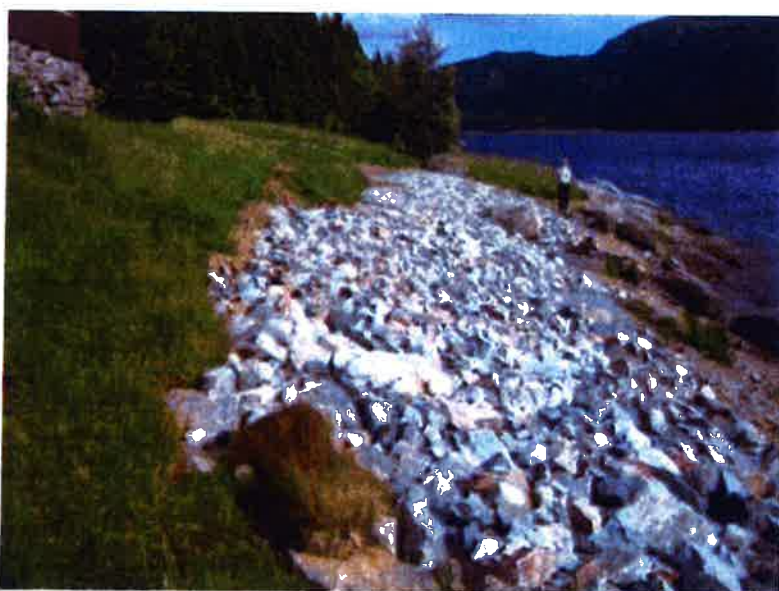
Foto 6. Kraftverket gjennomførte en plastring i juli 2013 (bildet tatt i juni 2014).
