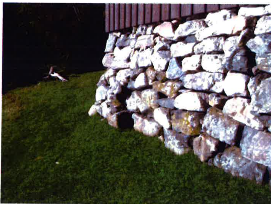
Foto 7. Foto av steinmuren tatt den 15.9.2011.
