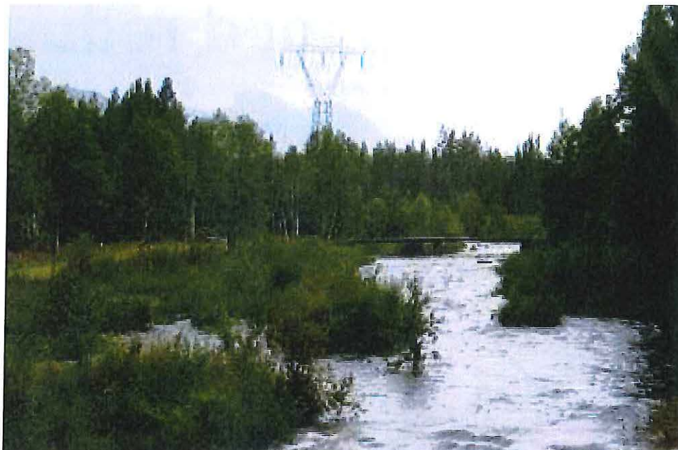
Det er anleggseiers ansvar å sørge for rydding av regulerte elvestrekninger slik at flomavledningskapasiteten er god nok. Mørkedøla, Hemsedal
