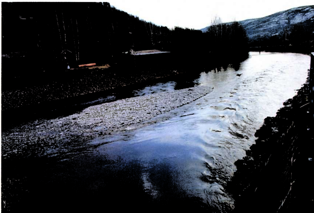
Figur 2. Vallaråi fra samløpet mellom tunellutløpet fra Sundsbarm kraftverk.
