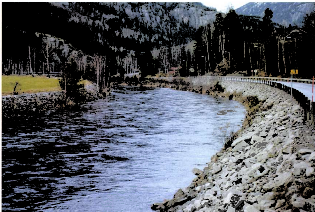
Figur 3. Eksempel på plastring av elvebreddene langs E 139 med sprengstein.
