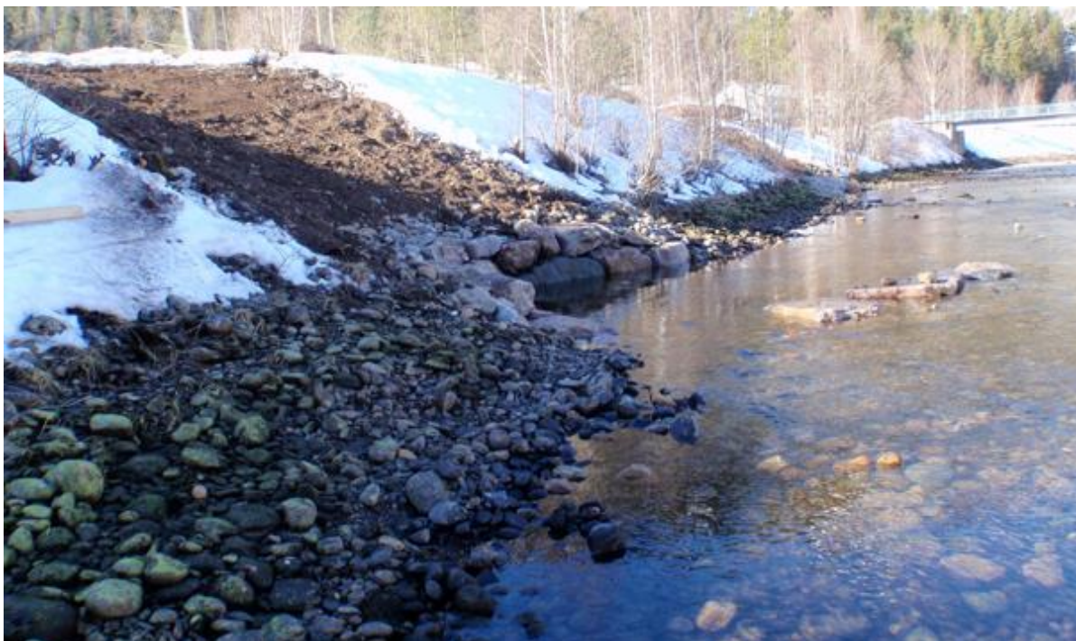
Figur 2.6. Etablering av kile med grovsteinede buner på elektrofiskestasjon 5 i Vallaråi. Selve kilen er bygd av grove steiner, og bunene utenfor styrer vannstrømmene inn i kilen (Kildal 2012; Kildal 2013).
