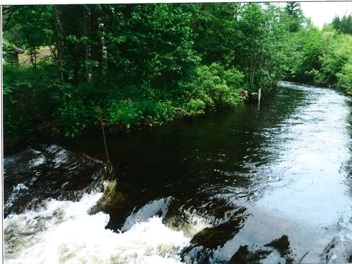
Figur 4. Morgedalsåi ved Vassendterskelen 4.7.2013 (etter nedbør). Foto Helge Kiland.
