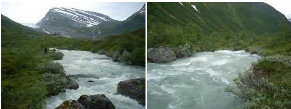
Bildene over viser sted for planlagt inntaksdam. Fotos: Ole Roer.
