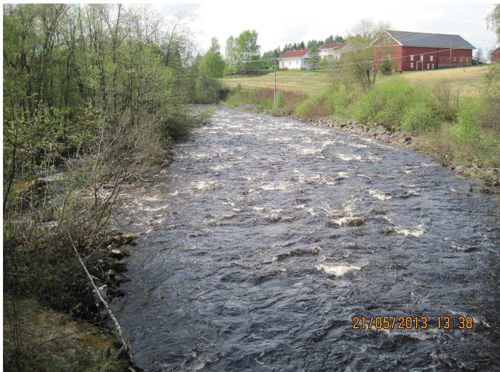
13. Sett vestover (med strømmen) fra Brattfossbrua: 4,0 m 3 /s
