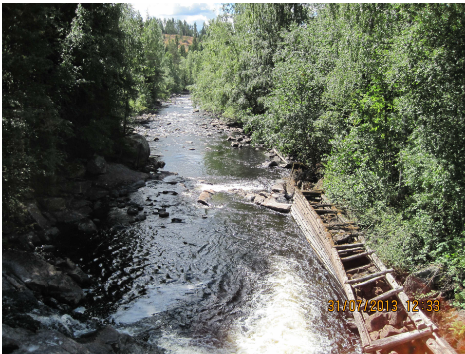
13. Utsikt fra Åflodammen ved minstevannføring 0,2 \text{ m}^3/\text{s} . Rester av tømret skådam sees til høyre på bildet.
