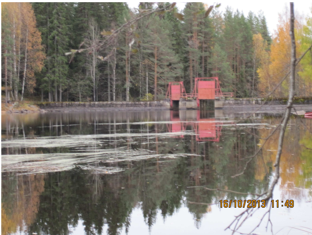
4. Store Åfloen og Åflodammen ved vannstand ca. 198,6 m. Bildet er tatt fra samme sted som bilde 3.
