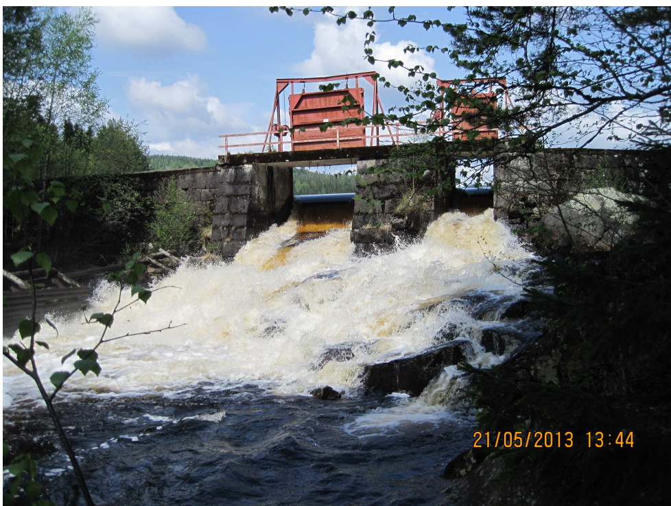
12. Stryket ut fra lukene i Åflodammen sett fra stein nedenfor dammen ved vannføring 4,0 \text{ m}^3/\text{s} .
