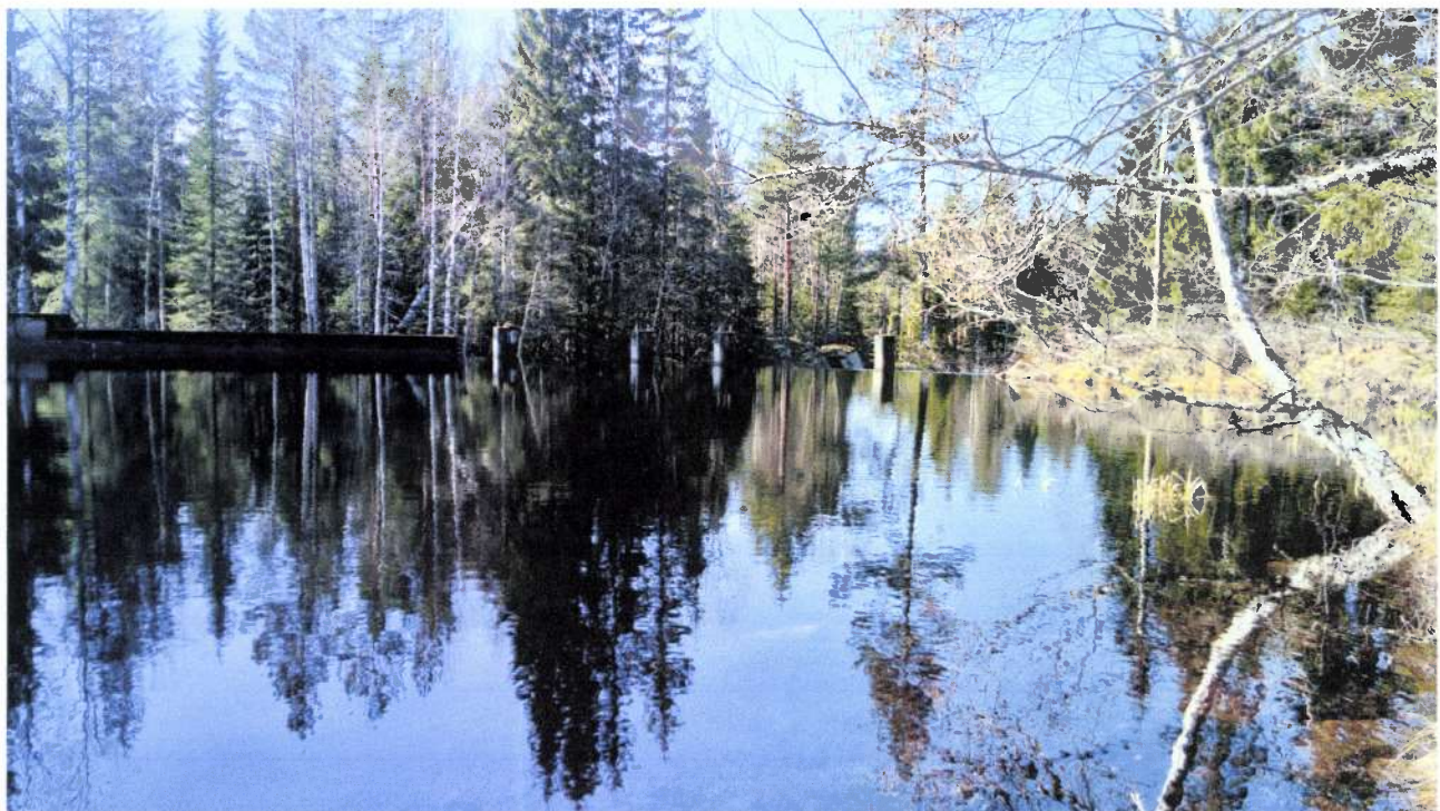
Begge bilder Bureisdammen (terskler)
