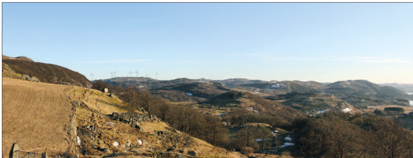
Bilde 4 Sikvalandskula vindkraftverk sett fra Høga Håland.
