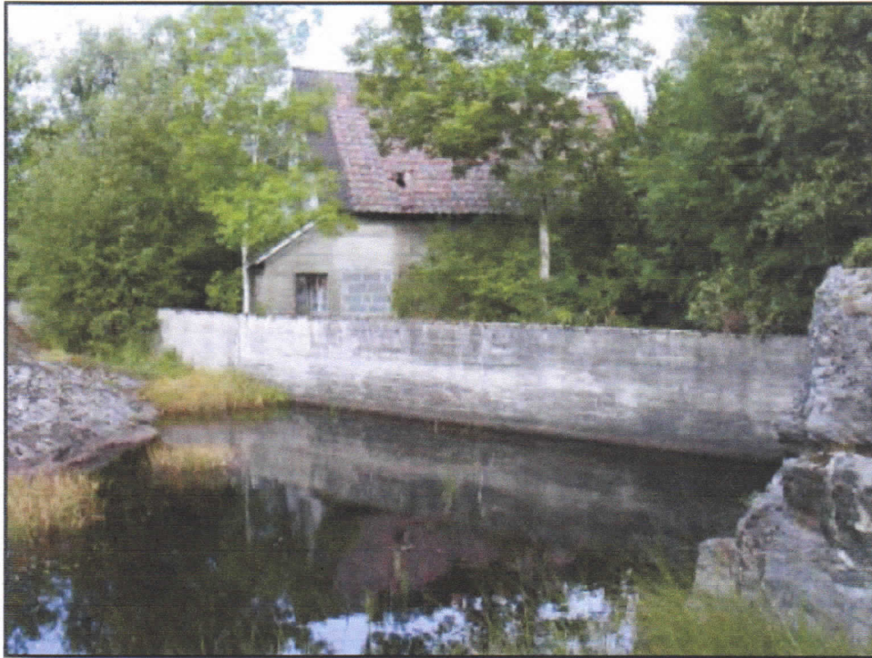
Figur 11. Kulturminne ved Sagvågaelva. Stemma vart laga m.a. for å sikra seg stabil vassføring til saga og kverna i Sagvågen. Restar av saga som ikkje vart brent sommaren 2006. Foto: Magnus Johan Steinsvåg.
