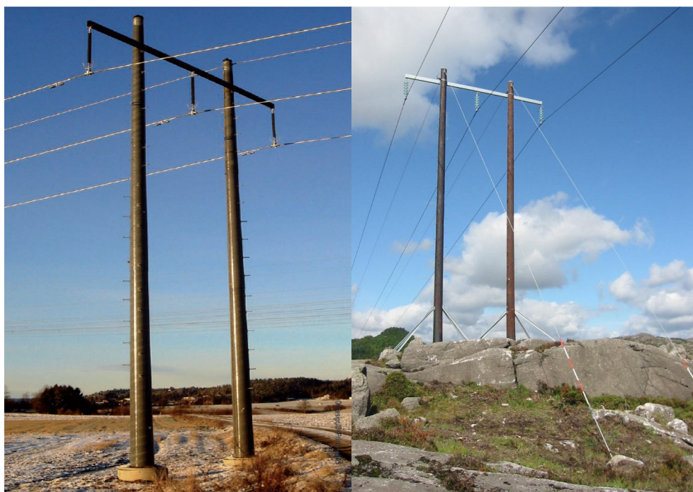
Figur 2-5 Eksempel på H mast ferdig bygd
