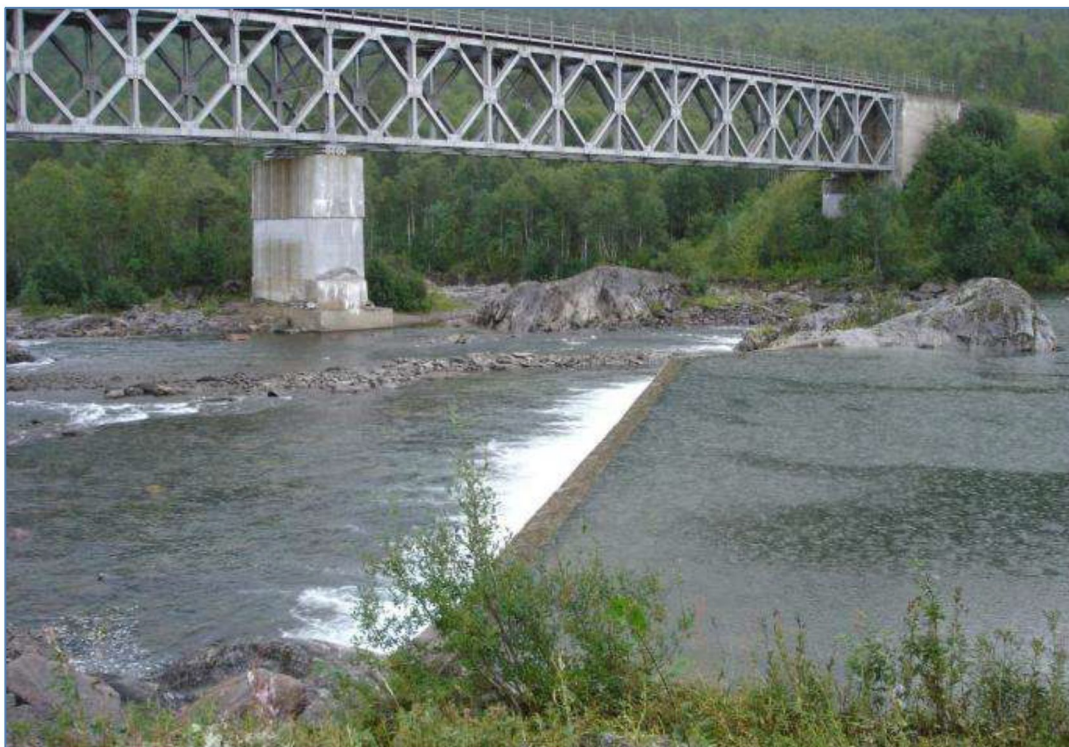
Figur 3-2 Eksisterende terskel ved ca. kote 245 i Ranaelva.
