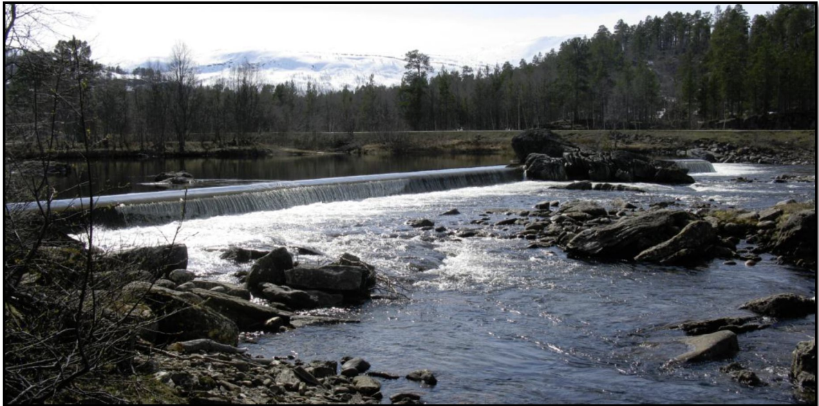
Figur 22 Område ved planlagt inntak i Ranaelva
