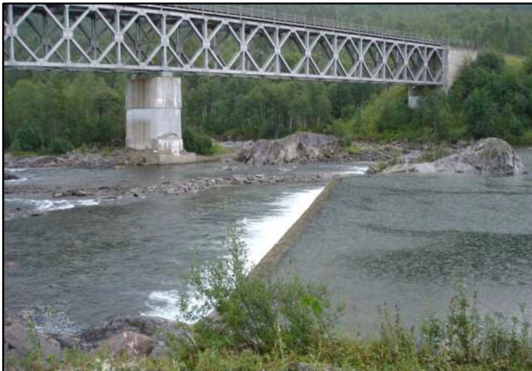
Figur 4-2. Eksisterende terskel ved kote 245 i Ranaelva.
