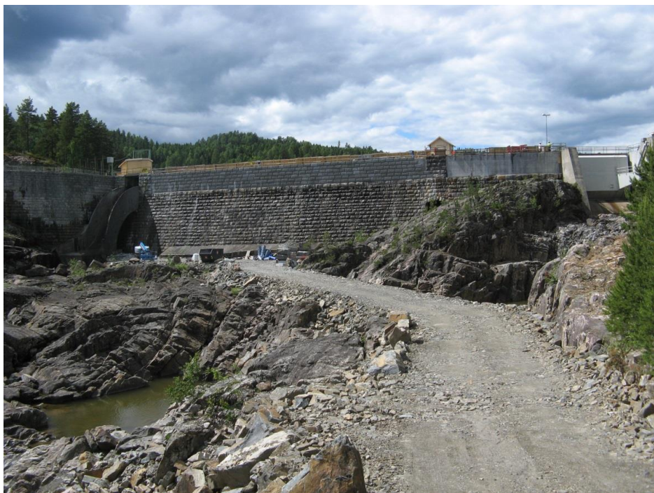
Figur 4 Rehabiliteringsarbeider på dam Dalsfos 25.06.2013.
