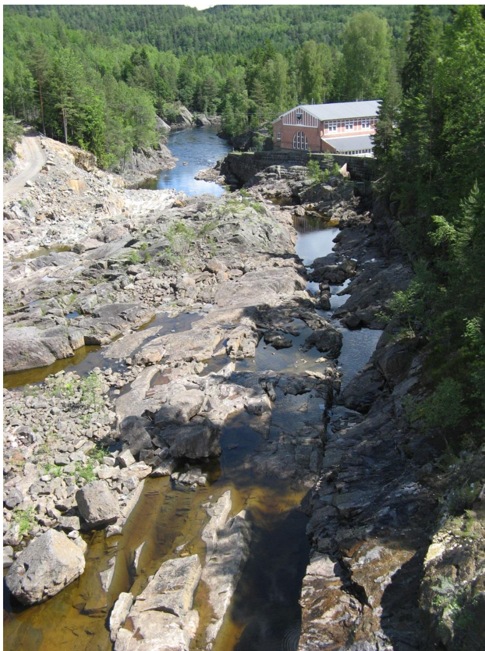
Figur 3 Dalsfos kraftstasjon med opprinnelig elvestreng 25.06.2013.
