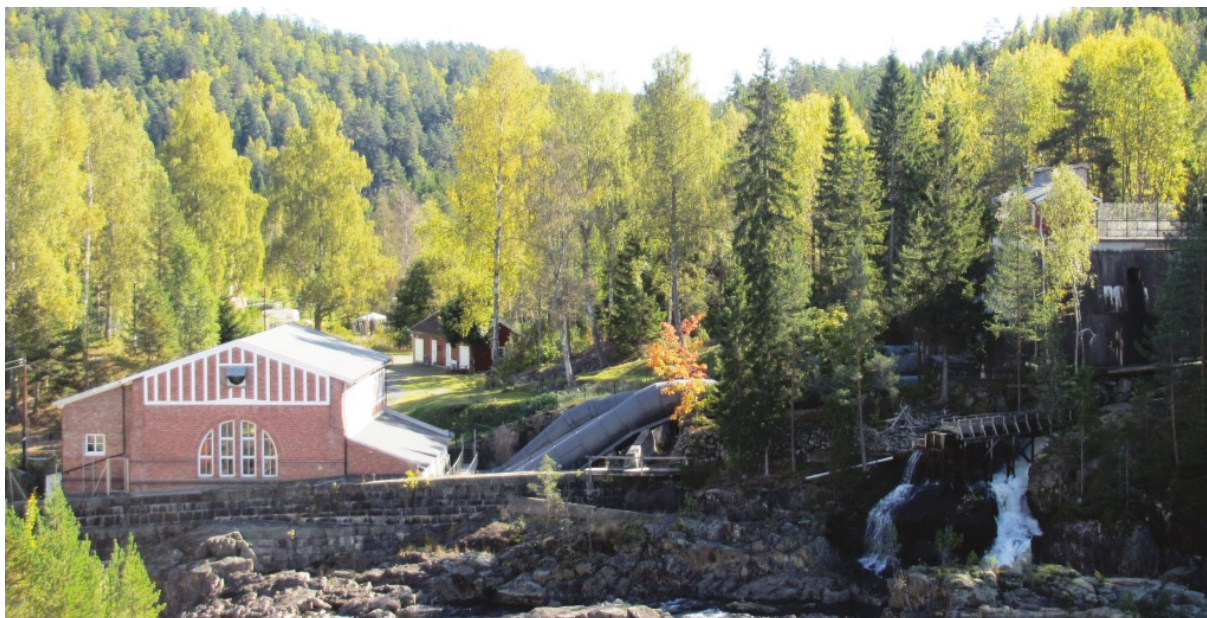
Figur 1.13 Dalsfos kraftverk sett fra nord. Inntaksdam og ålefelle til høyre.
