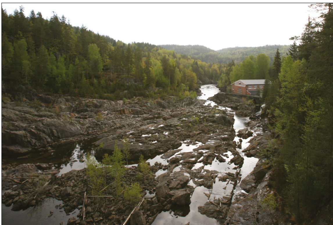
Figur 1.8 Dalsfos kraftverk sett fra reguleringsdam (19.05.2009)
