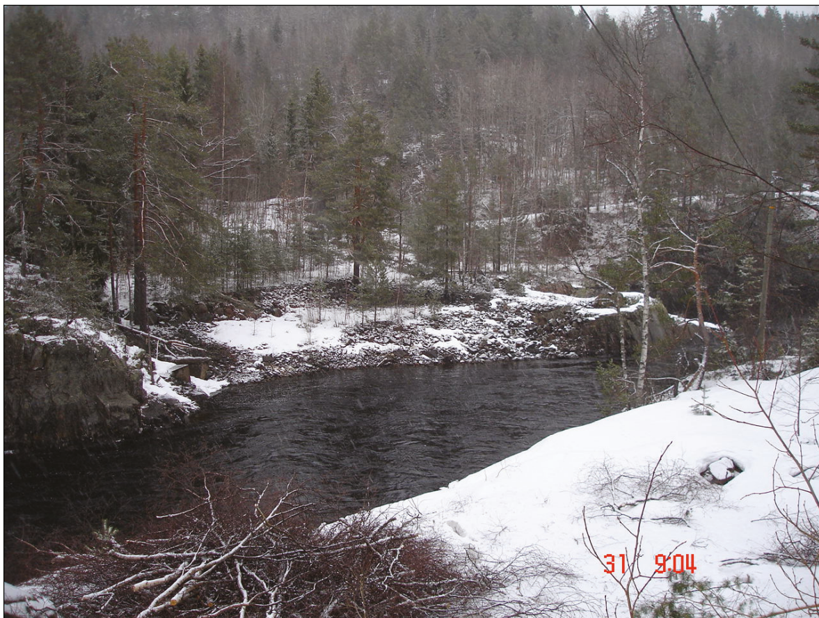
Figur 2.6 Området der avløpet fra kraftstasjonen kommer.
