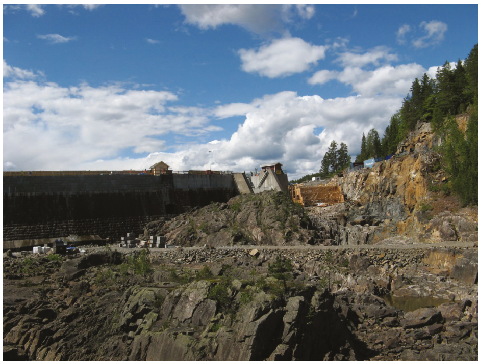
Figur 3.11 Dalsfos dam under rehabiliteringsarbeider sommeren 2013.
