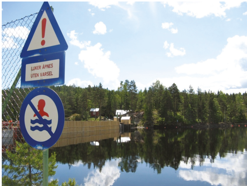
Figur 3.19 Avsperrert område oppstrøms nåledammen ved Dalsfos
