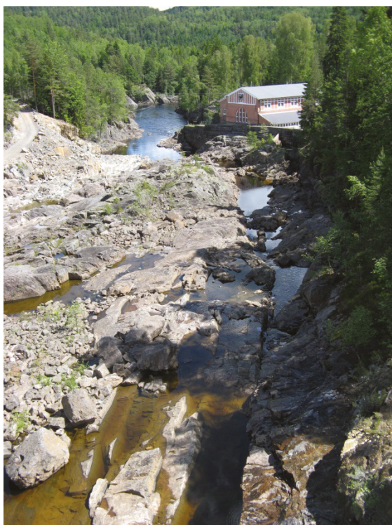
Figur3.13 Uttørret vannstreng sett fra dam.
