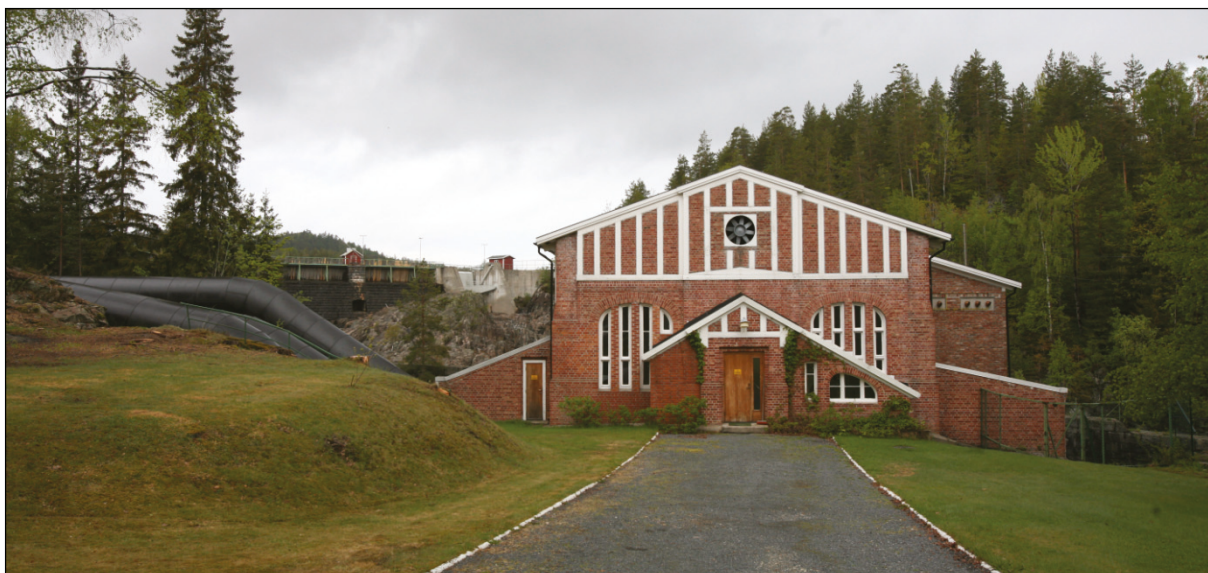
Figur 1.12 Dalsfos kraftverk med reguleringsdam i bakgrunnen
