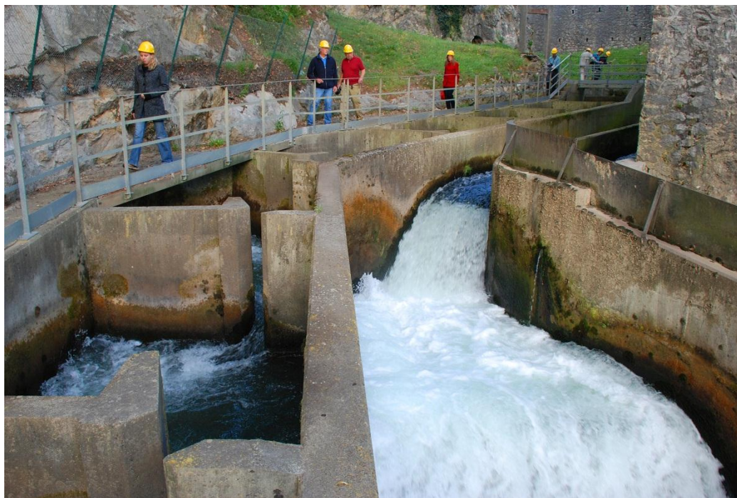
Figur 3. Spaltetrapp med parallelle løp for attraksjonvann og sideløp for smolt i Gave d'Pau, Frankrike. Foto: Morten Kraabøl, NINA.
