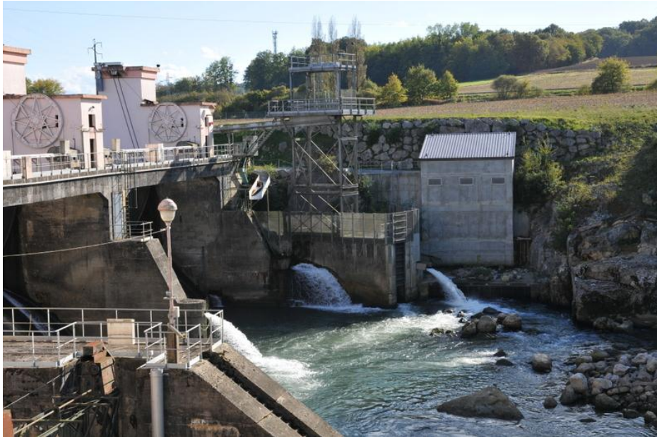
Figur 7. Fiskeheis ved kraftverket Baigts i elva Gave de Pau, Frankrike. Foto: Frode Kroglund, NIVA.
