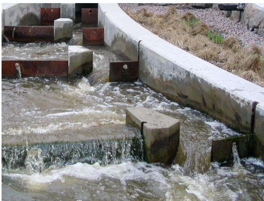
Figur 5. Spaltetrapp i Fyrisån, Sverige. Foto: Cmglee, en.wikipedia
