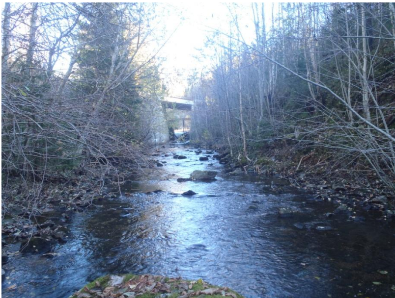
Bilde 4.7.1: Bilde fra Sandneslangen, fysisk oppgangshinder sees under bru, september/oktober 2010.
