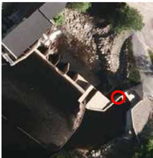
Figur 2. Flyfoto over Fosstveit kraftverk (kilde: Norge i bilder). Slipplokaliteter for PIT-merket ål oppstrøms (rød sirkel) og nedstrøms (gul sirkel) kraftverket, samt og to slipplokaliteter for ål merket med akustiske sendere (blå sirkel) er vist. Selve kraftverksdemningen er forstørret opp nederst. Tiltaksområdet er markert med rød sirkel. En skisse av kaplanturbinen som er installert ved kraftverket er også vist.
