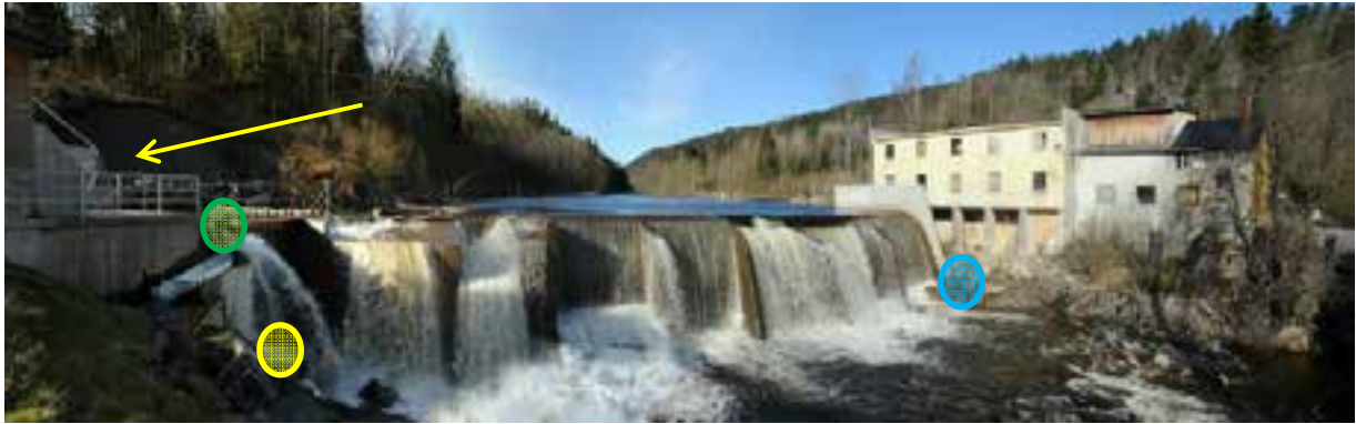
Figur 3. Dammen ved Fosstveit kraftverk fotografert i april 2012, med vanninntak til turbinen (gul pil), sideløp for nedvandrende anadrom fisk (grønn sirkel), laksetrapp for oppvandrende anadrom fisk (blå sirkel) og sideløp gjennom dammen for nedvandrende blankål (gul sirkel). Foto: F. Kroglund.
