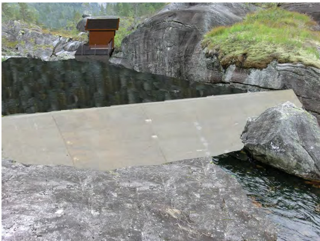
Bilde 7. Illustrasjon av dam og inntak.
