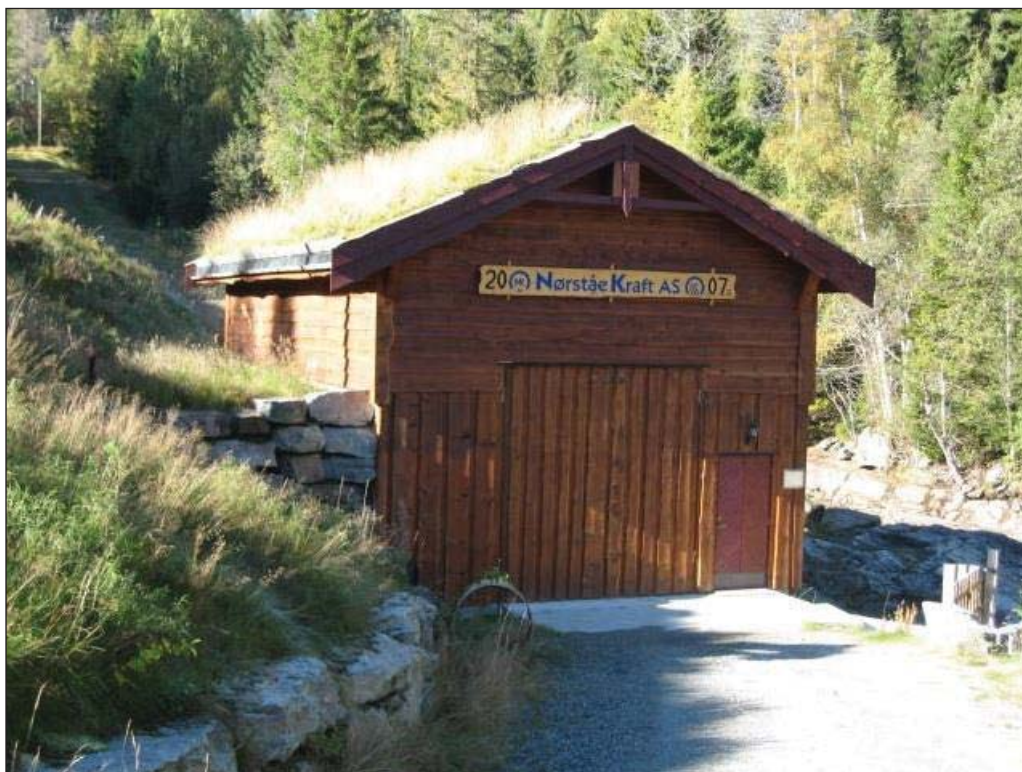
Bilde 4: Kraftstasjonsbygg for Nørstæ kraftverk, Rollag kommune, Buskerud fylke.
