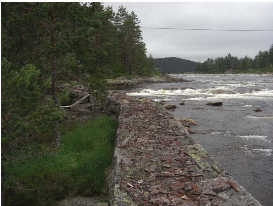
Bilde 7: Tørrmur sett oppover mot inntak. Antatt vannføring: 50 m 3 /s
