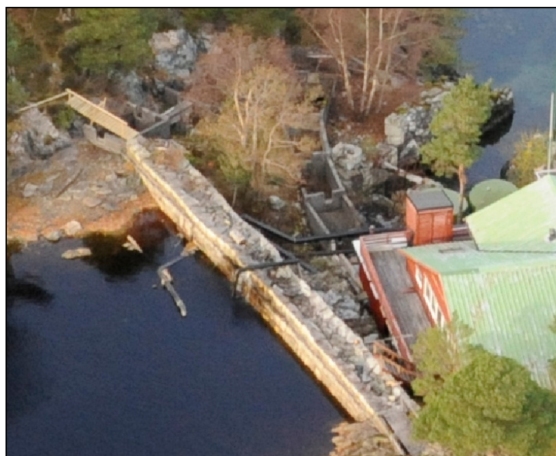
Figur 15. Oversiktsbilde som viser dammen ved utløpet av Sagevatnet. Settefiskanlegget ligger like nedenfor dammen. En ser også laksetrappen som ble bygget tidlig på 70 tallet og som kommer opp på siden av demningen til venstre i bildet.
