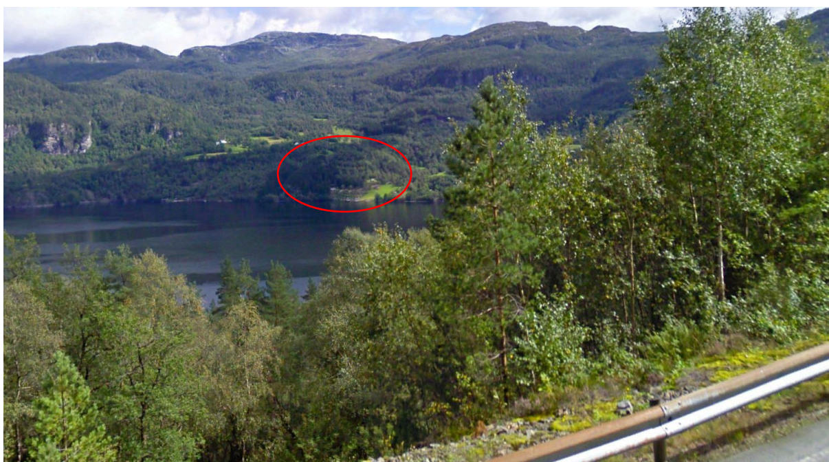
Figur 3.8 Tiltaksområdet sett fra andre siden av Saudafjorden
