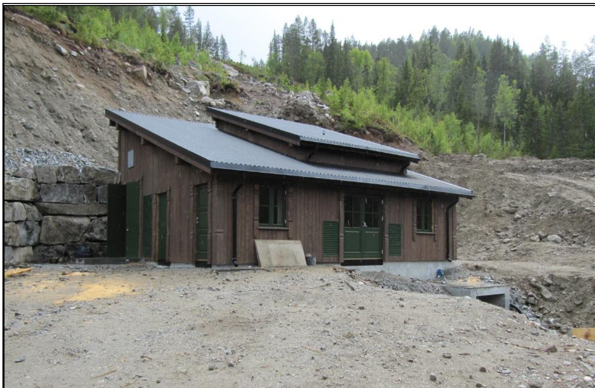
Figur 2.19 Eksempel på stasjonsbygg
