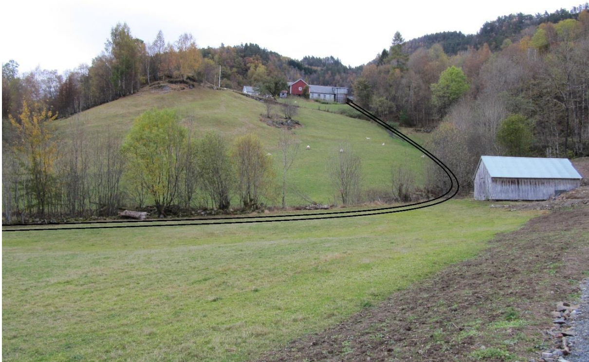
Figur 2.13 Rørgatetraséen, terreng øvre del
